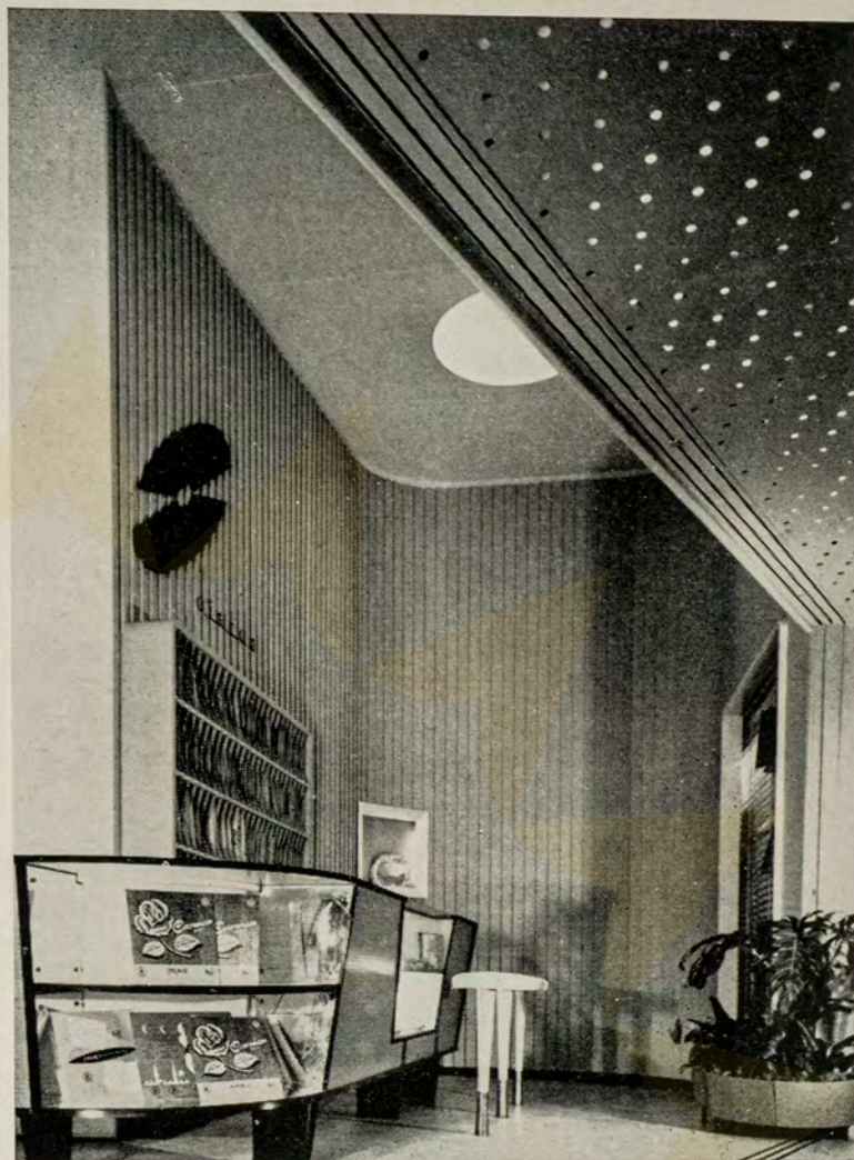
Entrada da loja. Lambris de pinho pintados cinza claro. Bancos fixos engastados no piso. Teto de chapa de aço perfurada, pintada de amarelo
