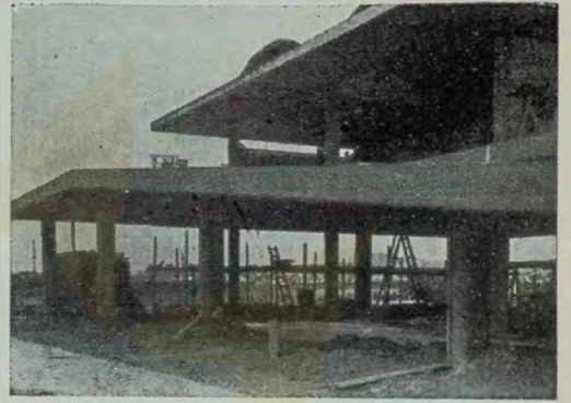
A obra em fase de construção.
