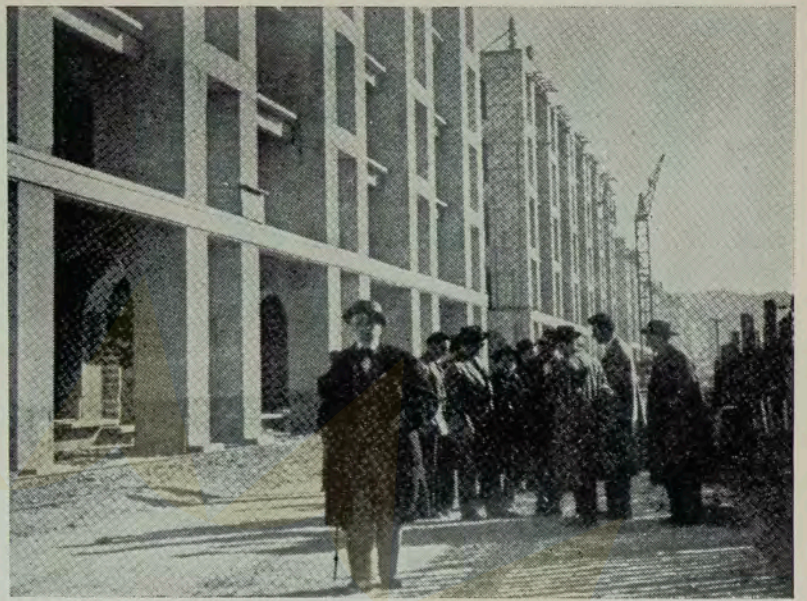
Perret, inspecionando a reconstrução de Le Havre, 1943.
