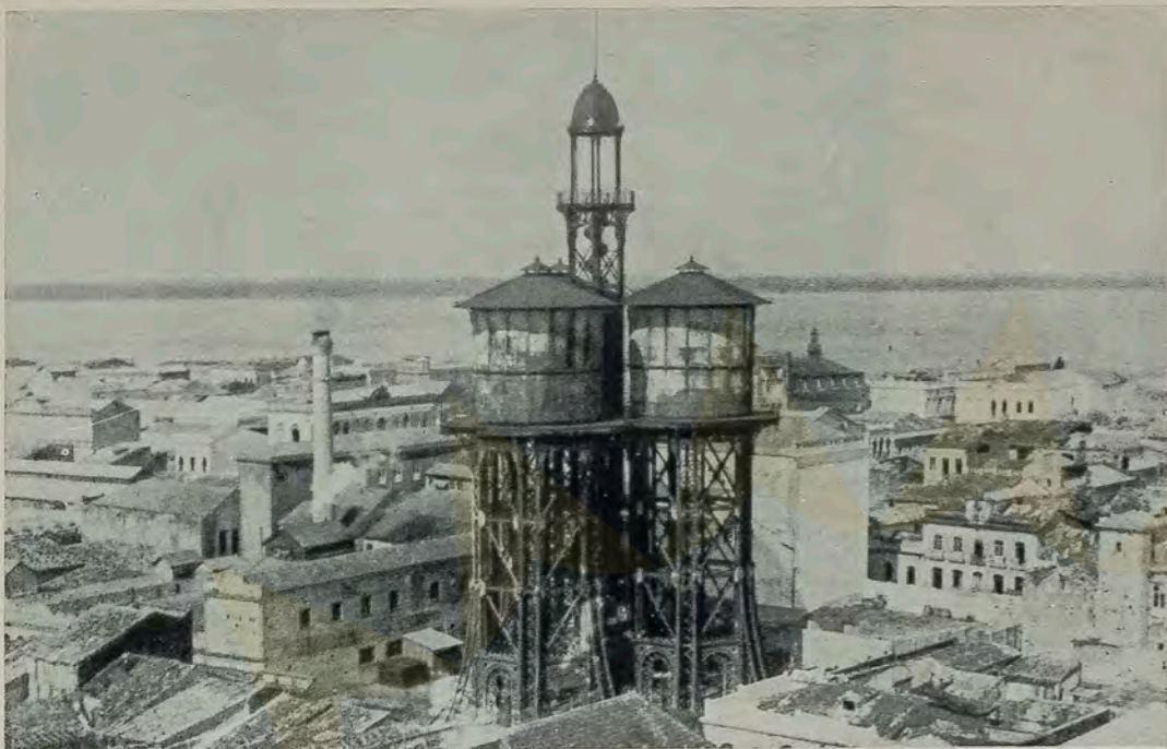
Reservatório "Pais de Carvalho", Belém, Pará.
