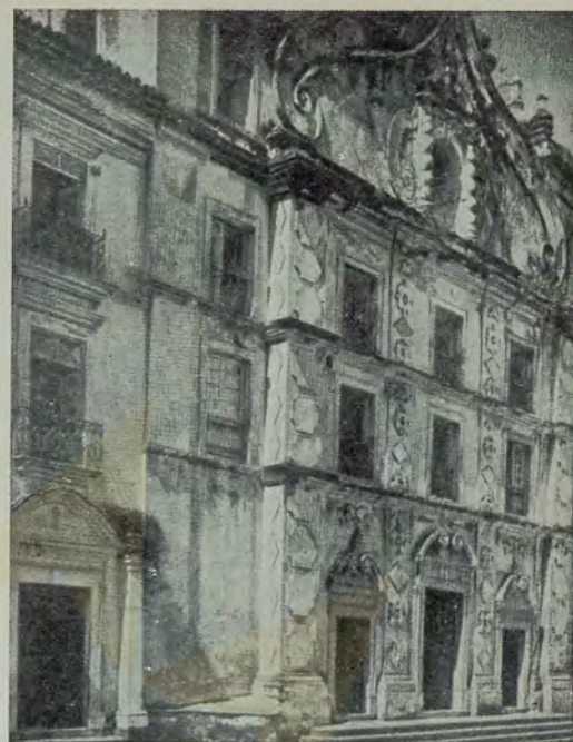
Fachada da igreja de São Francisco Xavier, Belém do Pará.
