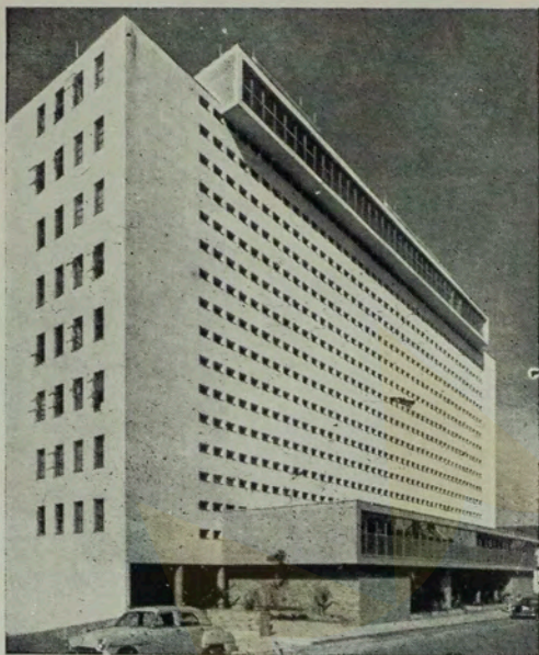
Instituto Central do Câncer, à rua José Getúlio, em São Paulo, uma das nossas últimas construções.
