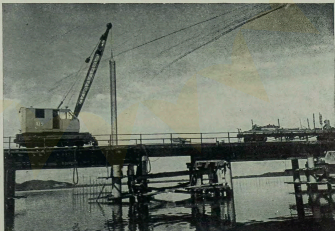
Reparação da ponte sobre o canal dos Barreiros, em São Vicente. Linha Santos-Juquiá.
