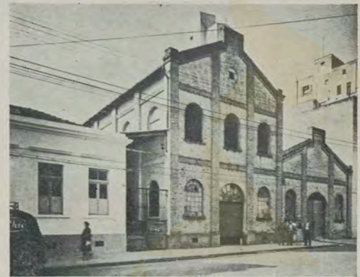
Aspecto do prédio onde está localizada a loja, antes de sua modernização.
