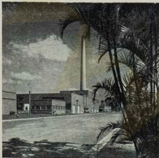
Casa de força de todo o complexo.
