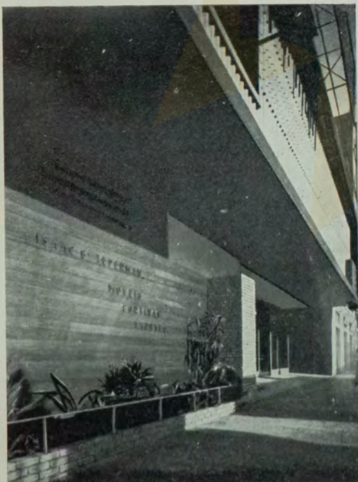
Vista da rua, observando-se como elemento decorativo e de vedação, um painel em madeira.
