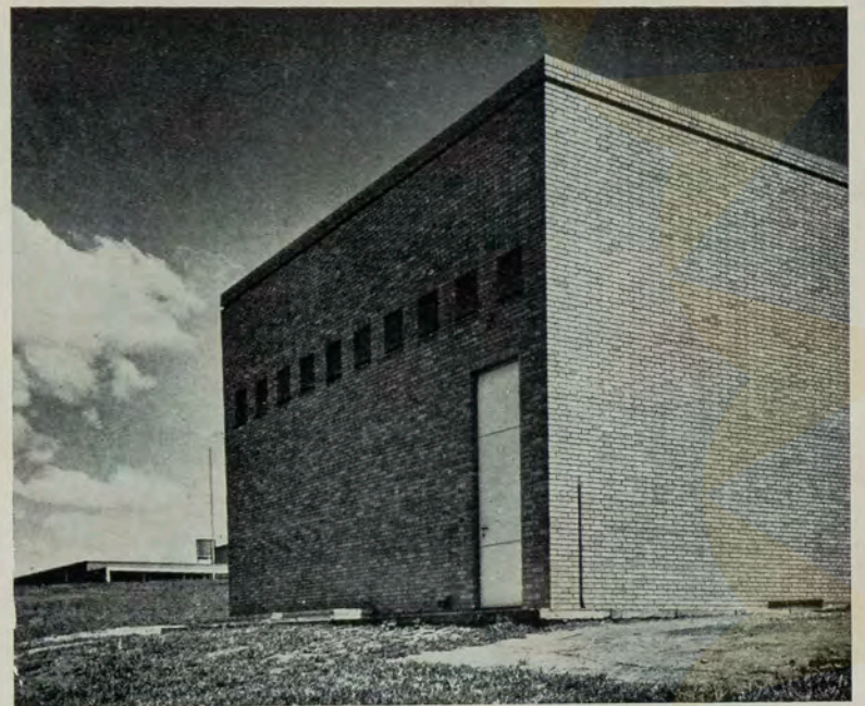
Cabine primária do conjunto.
