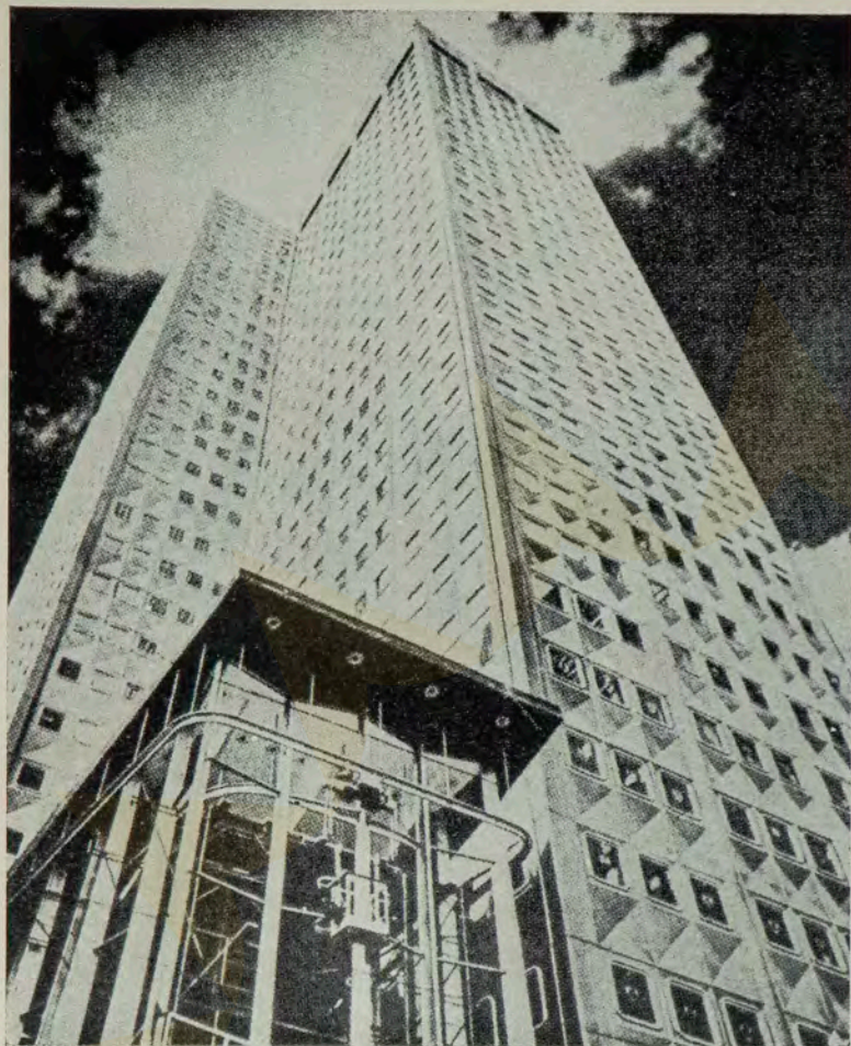
O mais alto edifício pré-fabricado do mundo: o prédio "Aluminium-Industrie"
