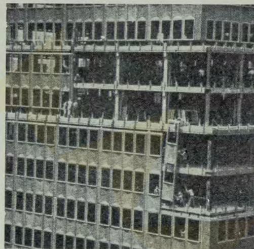
Montagem de elementos pré-fabricados em alumínio, no edifício de escritórios, ilustrado na página anterior. Foram colocados m.o.m. 700 elementos pré-fabricados. Cada um deles abrange dois andares e tem 1,35 ms de largura, 7 ms de altura e pesa 90 ks. Não foi necessário usar andaimes para a colocação.
