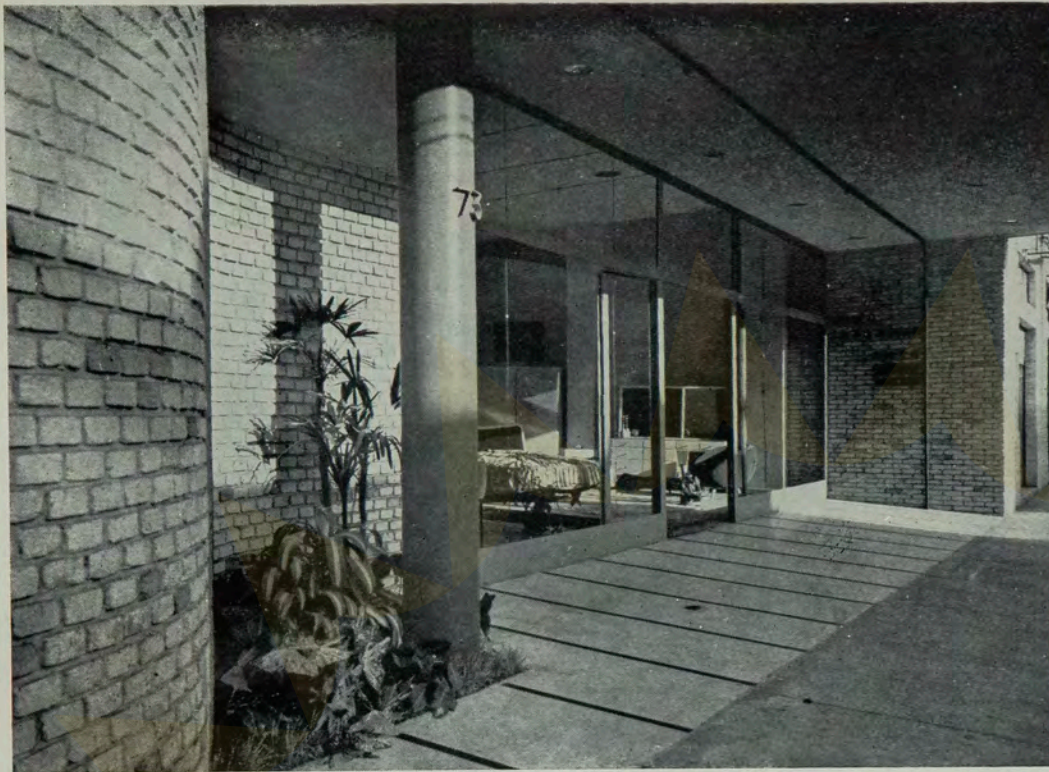
Vista da entrada da loja. Foram usados tijolos prensados para vedação e para a vitrine um painel de vidro em toda extensão.
