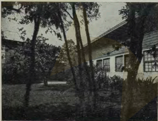
Aspécto da ala dos dormitórios do casal e hóspedes, notando-se o detalhe do beiral forrado com compensado e sarrajos a vista, com ventilação permanente para o fôrro devido o uso de telhas de fibro-cimento.
