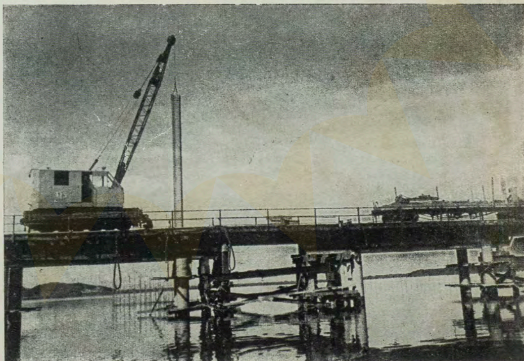
Reparação da ponte sobre o canal dos Barreiros, em São Vicente. Linha Santos-Juquiã.
