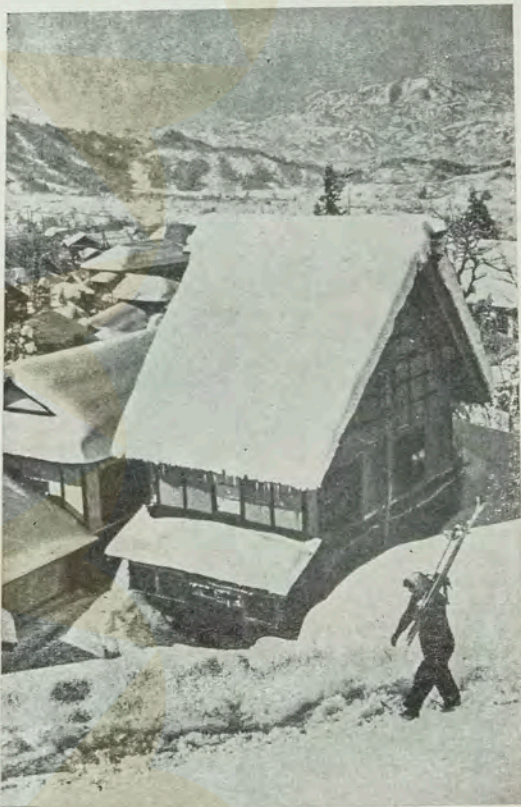
Telhados normandos que facilitam o escoamento das formações de neve.
