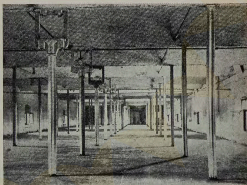
Estrutura com o miolo de ferro (colunas centrais e vigamento respectivo), da fábrica de Benyon and Bage (1796), Ditherington, Shrewsbury, Inglaterra (Foto do livro "Pioneers of Modern Design", de Nikolaus Pevsner).
