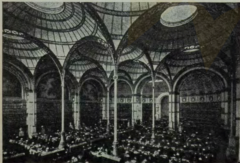
Salão de leitura da Biblioteca Nacional de Paris. Projeto de Henri Labrouste (1858-68). Cúpulas com estrutura de ferro revestidas de faiança esmaltada, assentes sobre colunetas de ferro. Na linha perimetral, também há colunetas, encostadas às paredes. A estrutura, toda de ferro está solta, dentro da caixa de alvenaria, que não conta para a sua sustentação (Foto: idem).
