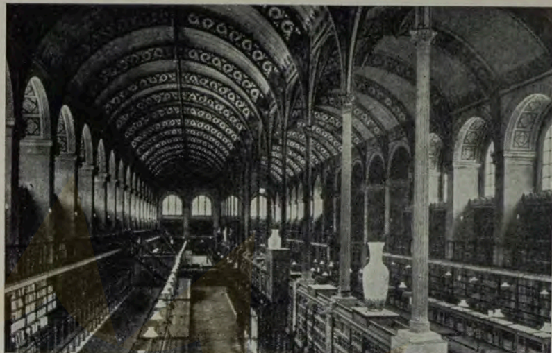
Salão de Leitura da Biblioteca de Santa Genoveva, de Paris. Projeto de Henri Labrouste (1841-50). Arcarias geminadas, "a-jour", assentes, ao centro, em colunetas de ferro fundido e em torno, em paredes de alvenaria (Foto de "L'Architecture Française", de M. Dormoy).
