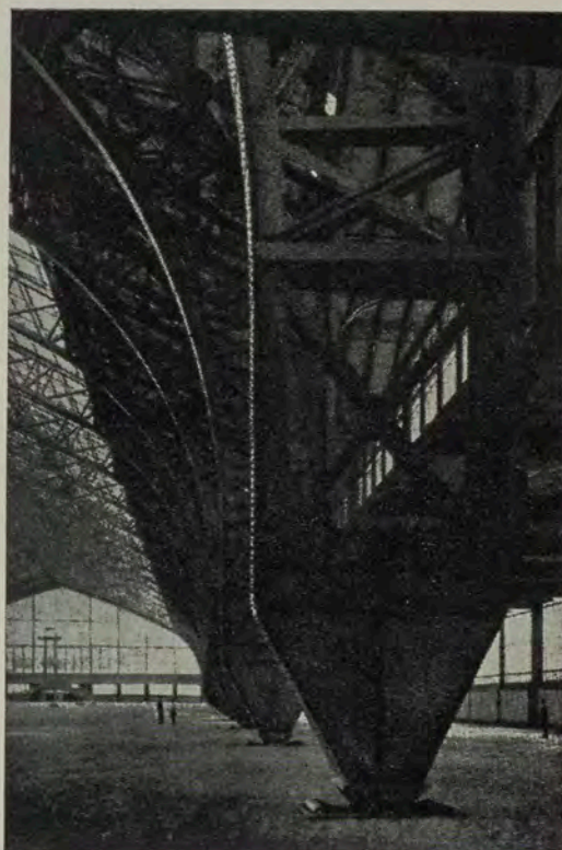
Pormenor da Galeria das Máquinas da Exp. Intern. de 1889, em Paris. Vão livre de 115 m (Foto do livro "Space, Time and Architecture", de S. Giedion).
