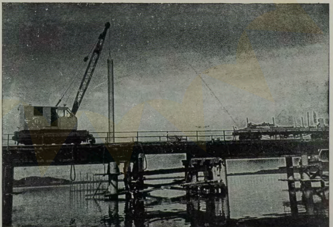
Reparação da ponte sobre o canal dos Barreiros, em São Vicente. Linha Santos-Juquiá
