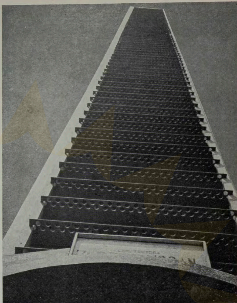
Detalhe dos elementos vasados de concreto.
