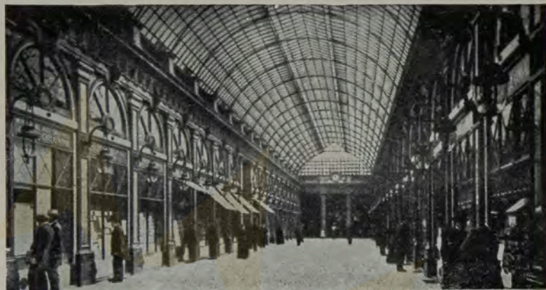
Galeria de Orleans, do Palais Royal, Paris. Projeto de Pierre Fontaine (1829). Berço inteiramente de ferro e vidro (Foto do livro: "L'Architecture Française", de Marie Dormoy).
