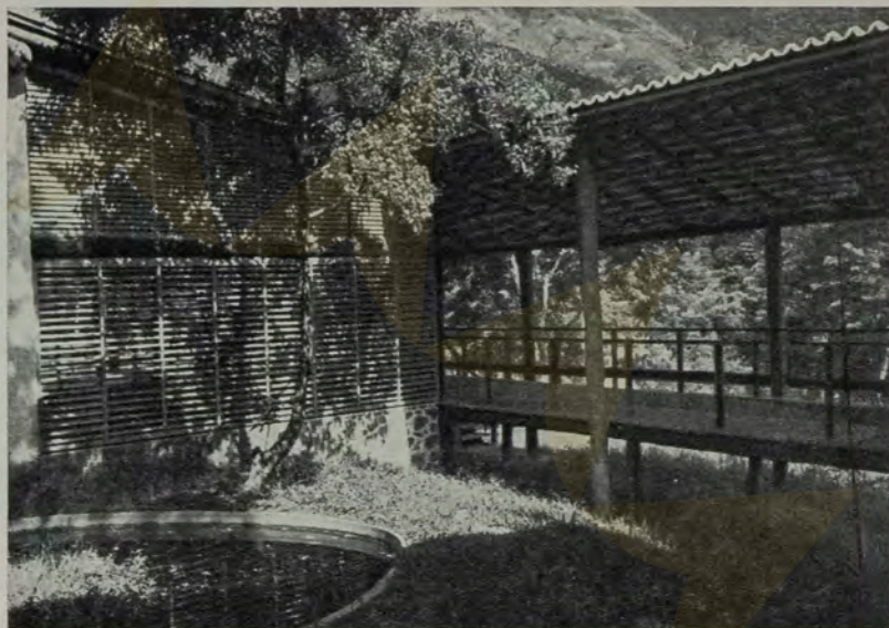
A outra fachada lateral da capela toda em venezianas de madeira: um perfeito estudo dos detalhes e encaixes de madeira.
