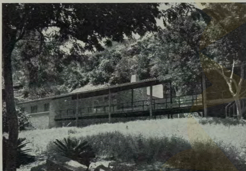
A varanda suspensa é toda de madeira, o piso é de peroba do campo, a estrutura de eucalipto e o balaustre de pinho de Riga.
