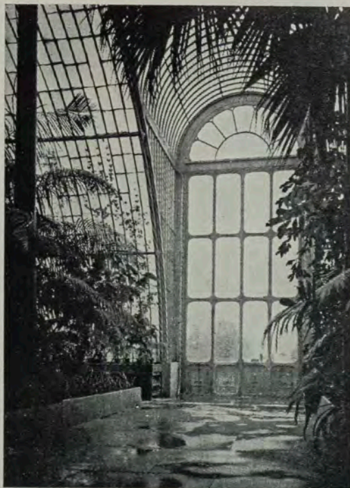
Estufa de Plantas, em Kew Gardens. Projeto de Decimus Burton e Richard Turner. (Início em 1844). Estrutura de ferro, com elementos modulados (Foto: idem).
