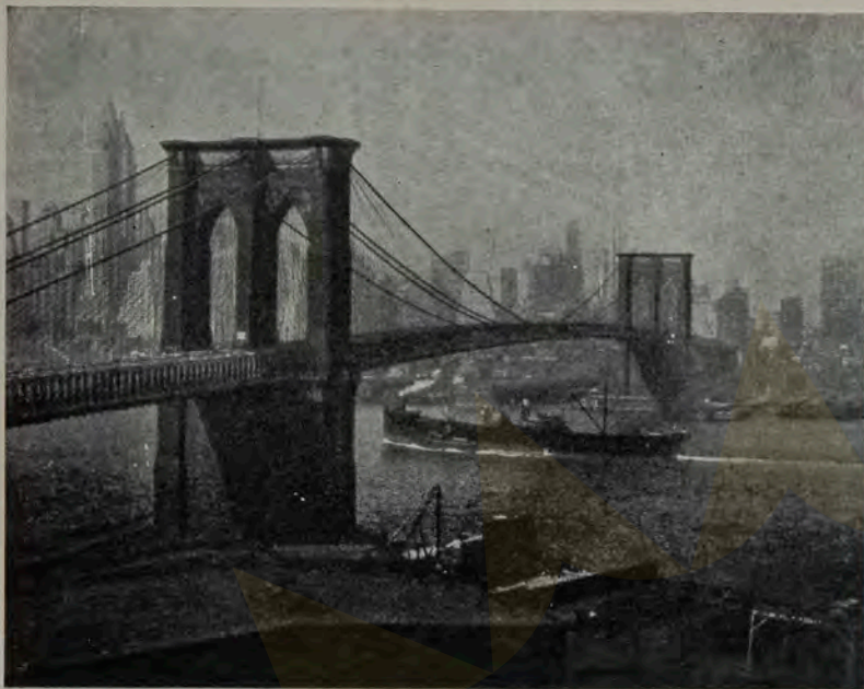
Ponte de Brooklyn, New York (1869-83). Projeto de John Roebling, executada por seu filho Washington A. Roebling. Vão livre de 486 m. Conflito entre a levêsa dos cabos de suspensão e o péso do neo-gótico dos apoios intermediários (Foto do livro "Architecture of Bridges" de E. B. Mock).
