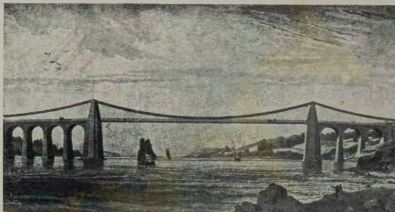
Ponte pênsil do Menai, em Wales, Inglaterra (1819-24). Projeto de Thomas Telford. Vão livre de 172 m. (Foto: idem).
