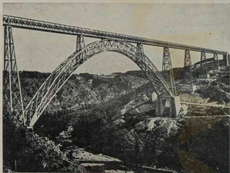
Viaduto do Garabit, na França. Projeto de Gustave Eiffel. Vão livre de 169 m. A preocupação com a esbelteza e a leveza vai ganhando a arquitetura das pontes (Foto: idem).
