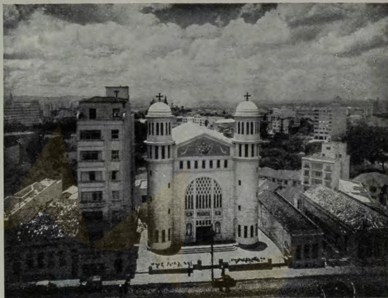
Aspecto do conjunto
