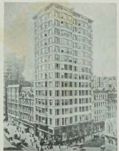
Unity Building, Chicago (1892). Clinton J. Warren, arquiteto e construtor. A gaiola de ferro, em toda a sua leveza e elegância, inovação que revolucionaria a Técnica de Construção e a Arquitetura (Foto: idem).
