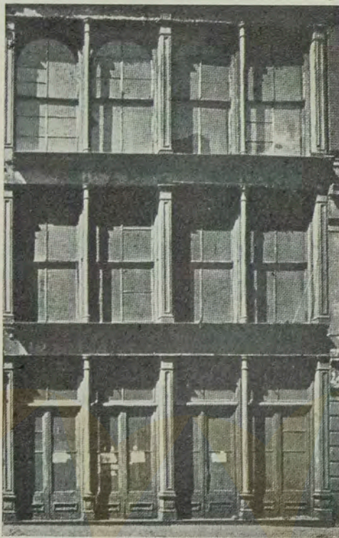
Fachada inteiramente de ferro, de um dos prédios do bairro de River Front, na cidade de St. Louis, nos Estados Unidos, datando de 1849-50 (Foto do livro "Space, Time and Architecture", de Siegfried Giedion).
