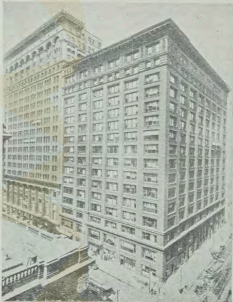
Marquette Building, Chicago (1894). Holabird & Roche, arquitetos e construtores. A firmeza do traçado resulta da marcação fornecida pelo esqueleto (Foto: idem).
