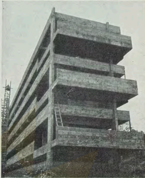
Aspectos da Construção.
