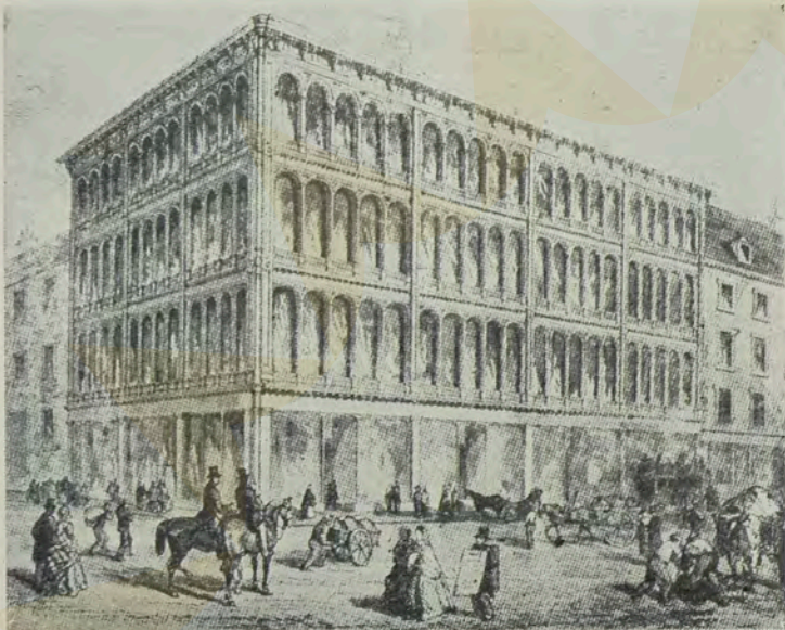
Armazens da rua Jamaica (Glasgow, 1855-56). Foi na década 1850-60 que surgiram, nos Estados Unidos, edifícios como os Armazens da Harper Brothers, de James Bogardus e na Inglaterra, êsse da rua Jamaica, com estrutura de ferro inclusive na fachada principal, tratada à imitação da Renascença Veneziana (Foto do livro "Pioneers of Modern Design", de Nikolaus Pevsner).
