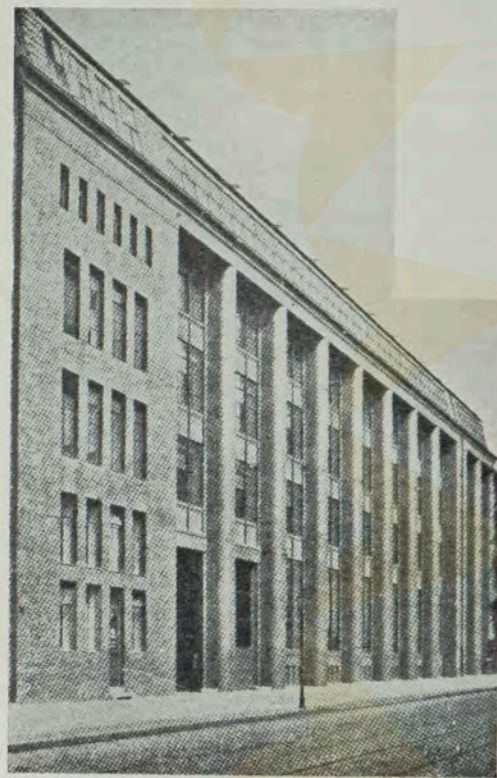
Fábrica de Eletricidade A.E.G., Berlin (1909). Peter Behrens, arquiteto. Domina o sentimento estrutural (Foto do livro "European Architecture in the Twentieth Century", de Arnold Whittick).
