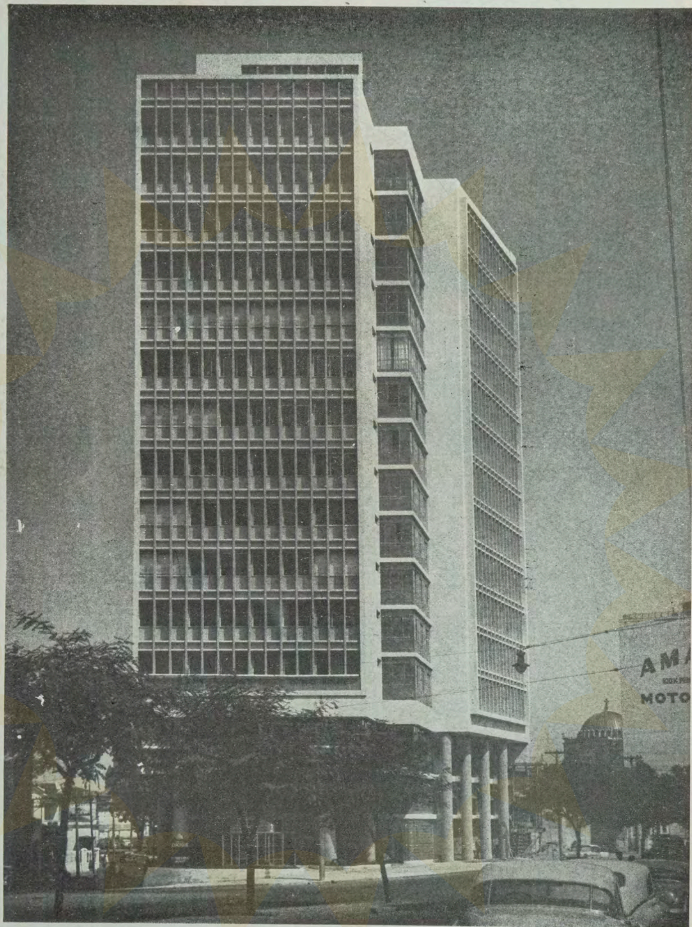
EDIFÍCIO CACIQUE — SÃO PAULO PROPRIETÁRIO: JORGE C. CASSAB E OUTROS CONSTRUTORES: ALBERTO BADRA, MIGUEL BADRA JR. & CIA. LTDA.
