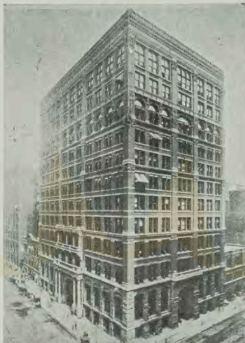
Home Insurance Building, Chicago (1883-85). William Le Baron Jenney, arquiteto e construtor. Primeiro arranha-céu com esqueleto inteiramente de ferro, do mundo. Inicialmente com 10 pavimentos (Foto do livro "The Rise of the Skyscraper", de Carl W. Condit).
