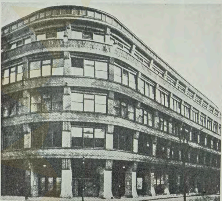
Edifício de Escritórios, Breslau (1912). Hans Poelzig, arquiteto. Desenvolve-se nessa época o partido dos dominantes horizontais, que tanta influência exerceria na arquitetura contemporânea. Mas as formas simples, de sentimento estrutural, dominam a composição (Foto do livro "European Architecture in the Twentieth Century", de A. Whittick).
