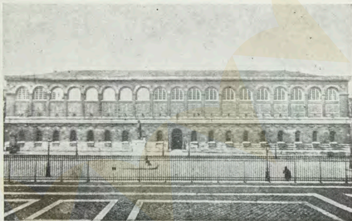
Biblioteca de Santa Genoveva, de Paris. Arquiteto Henri Labrouste (1841-50). Se Labrouste foi dos grandes precursores do emprêgo das estruturas de ferro no interior dos edifícios, no exterior usou abundantemente os envoltórios de alvenaria tratados em linhas historicistas (Foto do livro "L'Architecture Française, de Marie Dormoy).
