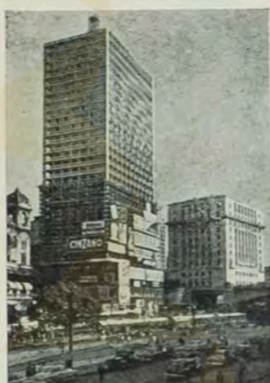
Edifício Conde de Prates, rua Líbero Badaró-Pr. do Patriarca, Av. Anhangabaú. Construtor: Construtora Alfredo Mathias S. A.
