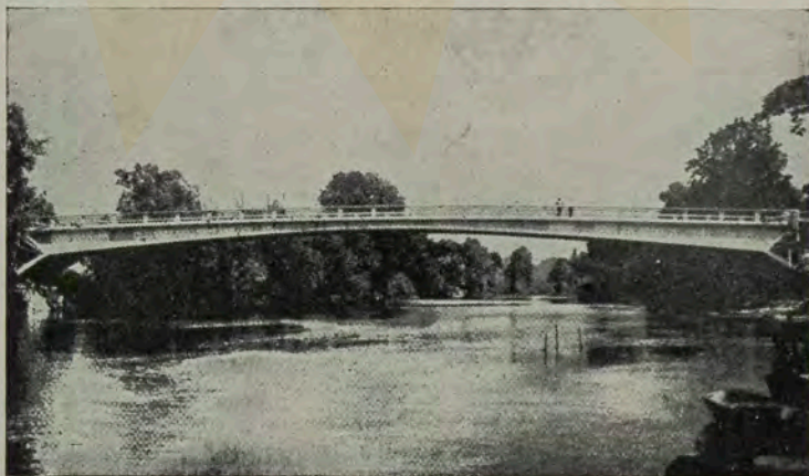
Ponte d'Esblly, sobre o Marne. Projeto de E. Freyssinet (Foto da revista “Techniques & Architecture”, número especial dedicado a Perret. Paris (1949).
