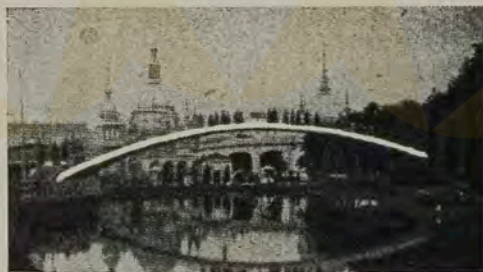
Pontes de concreto armado, construídas pelo sistema Monier, em Stern (1888) e Bremen (1890) (Fotos do livro "Handbuch für Eisenbetonbau", de F. Emperger, com a colaboração de M. Foerster, O. Graf, M. Thullie,
