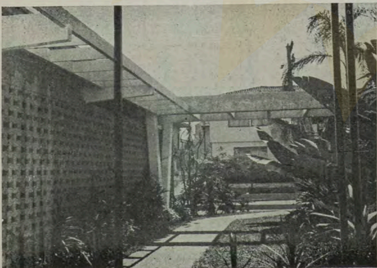
Aspecto da fachada lateral compreendendo os elementos vasados e a pérgola.
