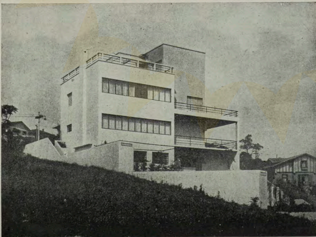
A bela residência Luiz Prado, construída no Pacaembú em 1930-31, o quinto trabalho realizado por Warchavchik.
