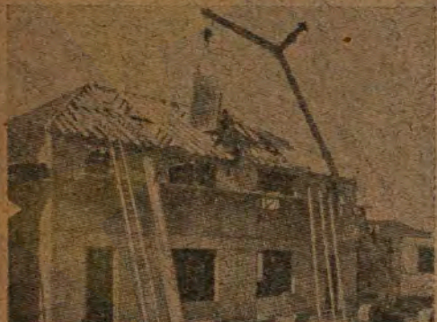
O sistema inglês Wates durante as várias fases de montagem dos elementos pré-fabricados.
