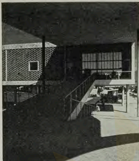
Rampa de acesso à escola.
