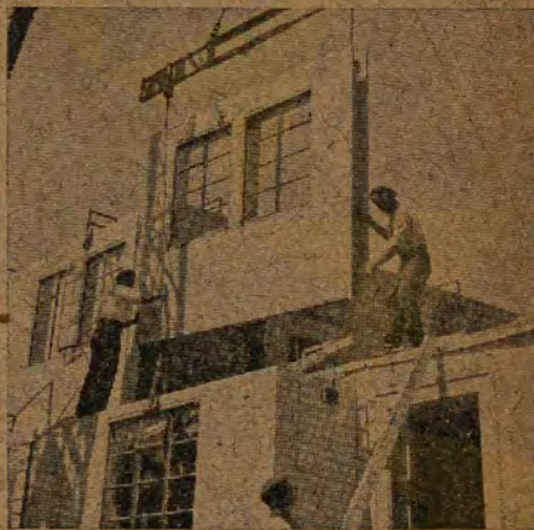
A montagem de uma casa com elementos produzidos em fábrica, desenvolve-se em poucos dias.
