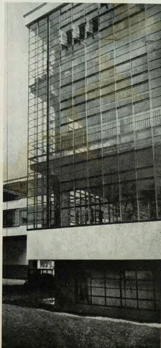
Um dos cantos do edifício do Bauhaus, mostrando a independência da estrutura. Dessau (1925-26). Arquiteto: Walter Gropius (Foto do livro "Walter Gropius", de S. Giedion, Paris, 1954). ➡
