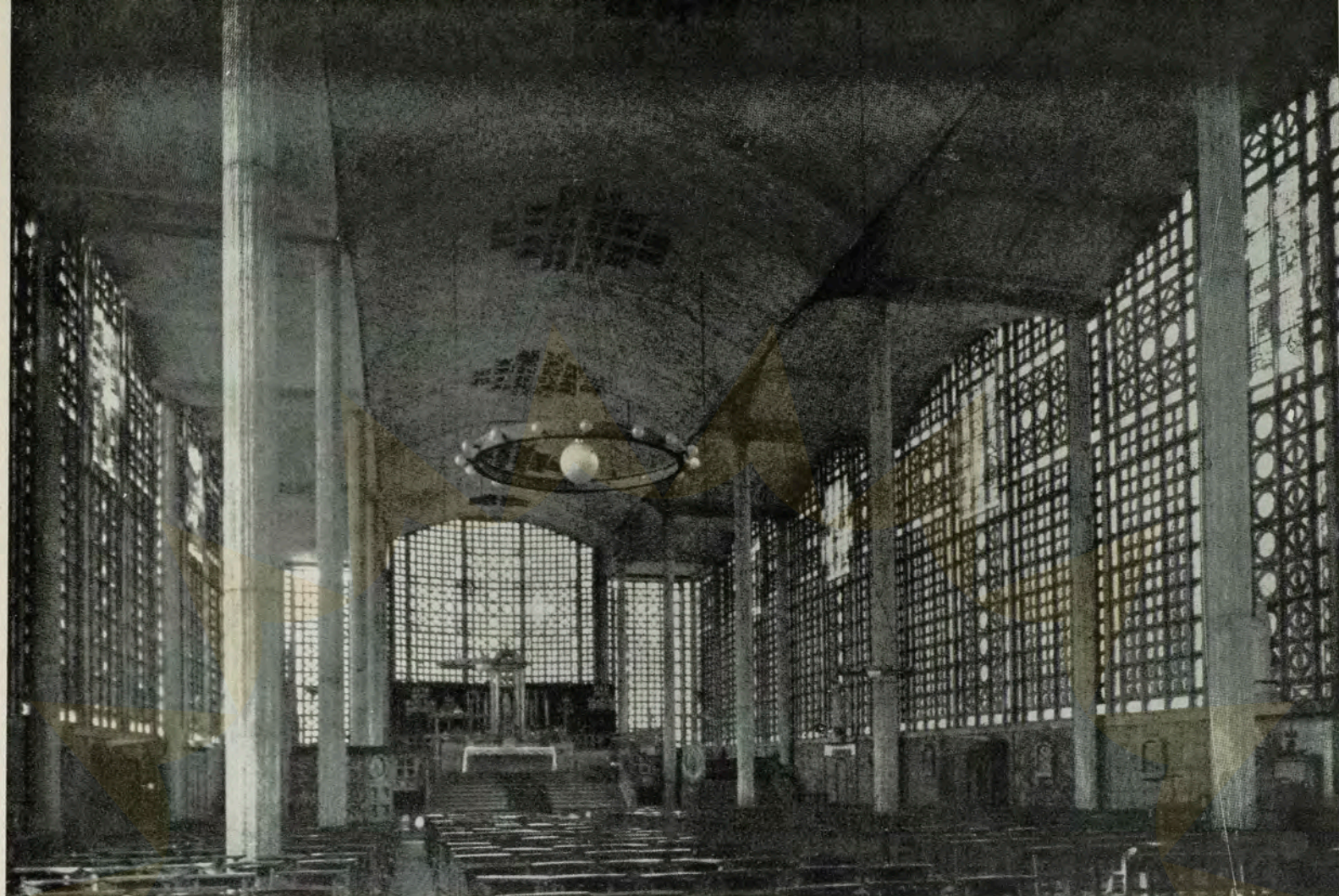
⤴ Interior da Igreja de Notre-Dame du Raincy mostrando a independência da estrutura (1923-25). Arquiteto: A. Perret (Foto do livro "Beton Kirche", de Ferdinand Pfammalter, Zurich e Köln, 1948).
