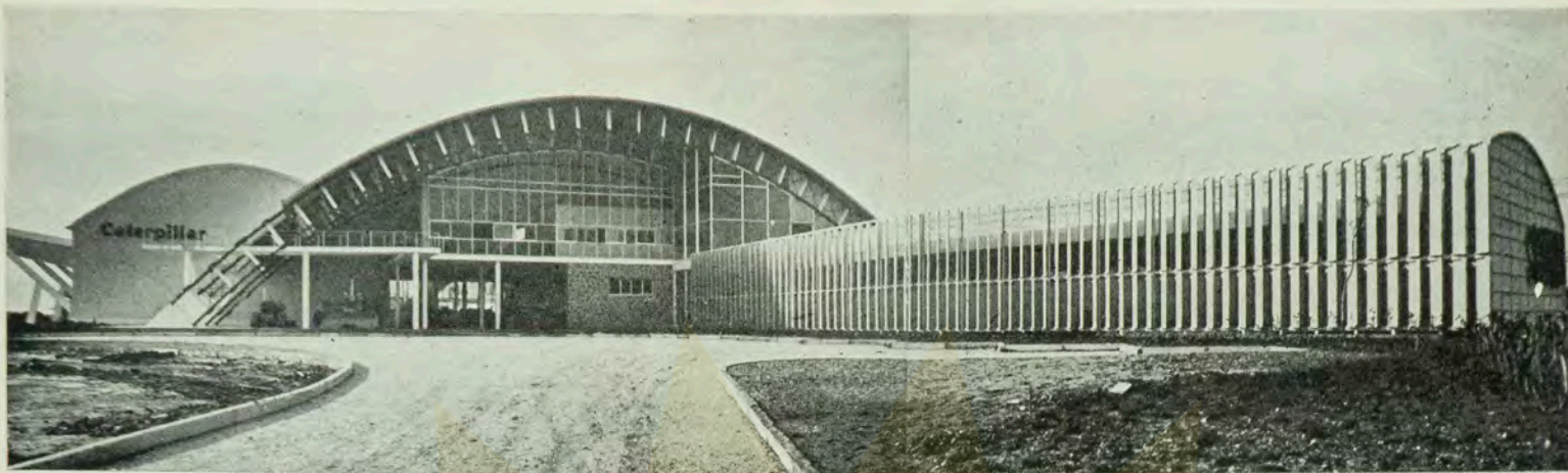
Arquitetura industrial dos M.M.M. Roberto: o edifício para a Caterpillar, com oficinas e escritórios, à avenida Brasil, Distrito Federal, projeto de 1949, em cuja brilhante conjugação de elementos se reúnem a engenharia e a arquitetura. Os quebrassóis tornam-se um elemento notável de decoração ao longo do corpo das oficinas.
