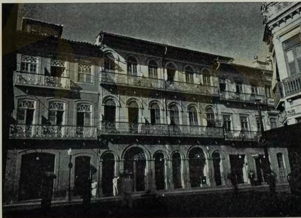
Casas da rua do Lavrádio, no Rio. Este conjunto de prédios foi, recentemente, demolido.
