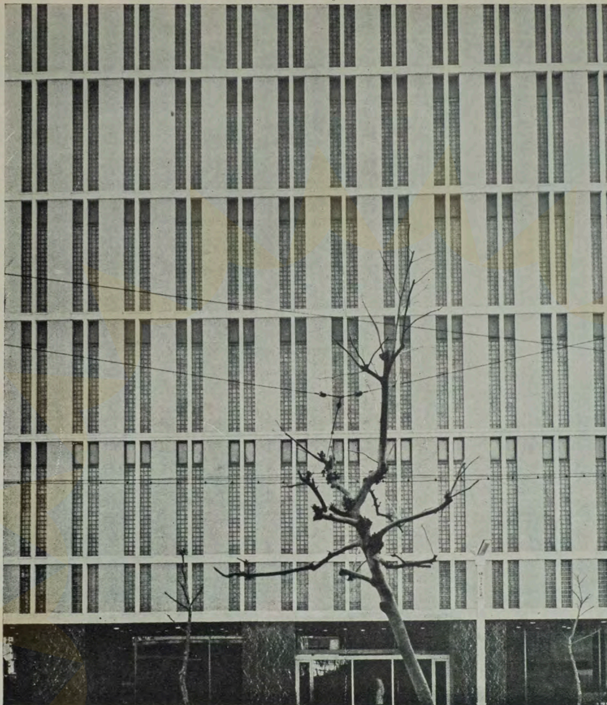
Arq. Togo Muraho, Edifício de escritórios da Central Telefônica, perto de Tóquio.
