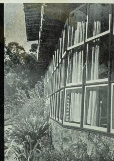
Os caixilhos, adequadamente colocados.
