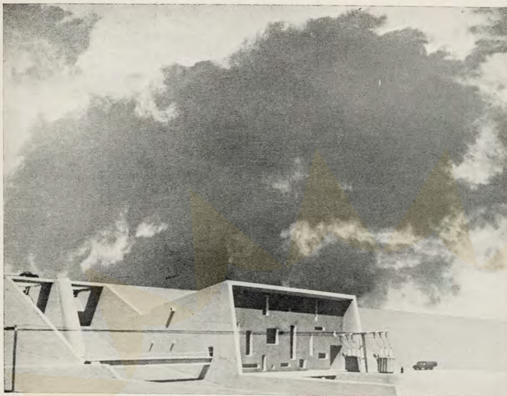
Casa de máquinas e extravasador. Ao fundo a barragem de terra (20 m.).
