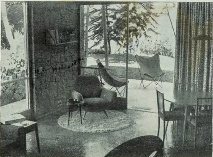
Ângulo da sala de estar. Paredes de alvenaria de pedra, com prateleira para livros em madeira e ferro.
