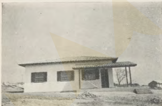
Em cima: Habitação do engenheiro (em construção). Em baixo: Habitação dos técnicos (em construção).
