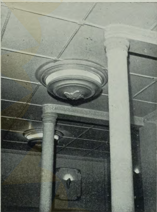
Duas vistas da aplicação de madeira incombustível em fôrros. Para acompanhar a decoração interior, foram pintados com tinta à base de resinas sintéticas.
