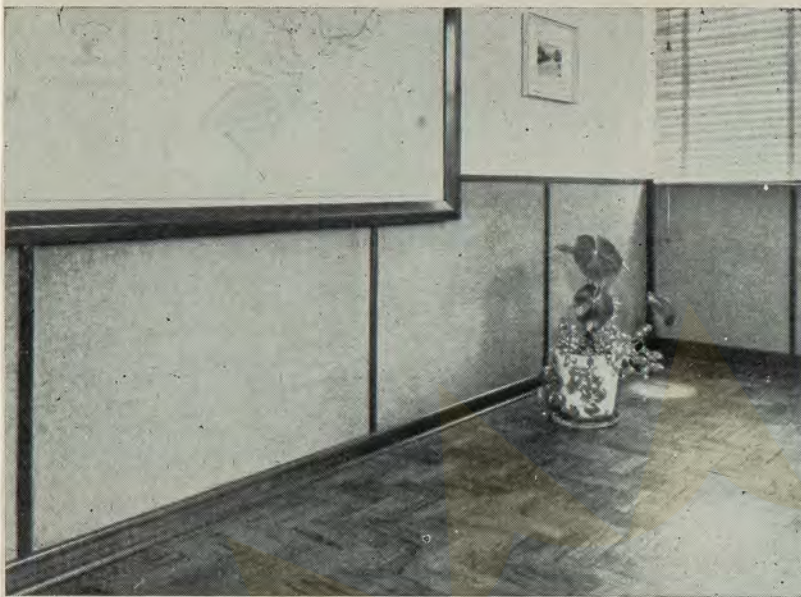
Aplicação da madeira incombustível em revestimento. Seu excelente acabamento, dispensou a pintura.
