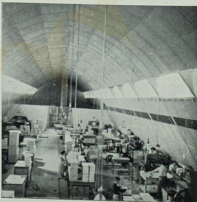
Aplicação da madeira incombustível em fôrro curvo, oferecendo plena segurança contra incêndios e custo de mão-de-obra bastante reduzido, porque dispensou a pintura.
