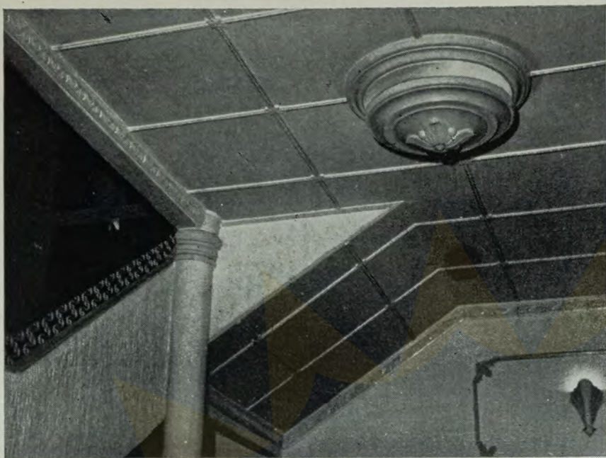
Duas vistas da aplicação de madeira incombustível em fôrros. Para acompanhar a decoração interior, foram pintados com tinta à base de resinas sintéticas.
