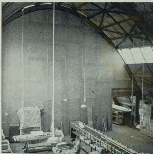
Divisão construída com madeira incombustível. Uma garantia contra incêndios. Não houve prejuízo da iluminação graças ao seu acabamento na tonalidade amarela pardacenta.
