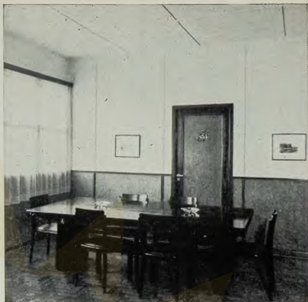
Porta construída com madeira incombustível. Mesa folheada com o mesmo material e acabamento em verniz.
