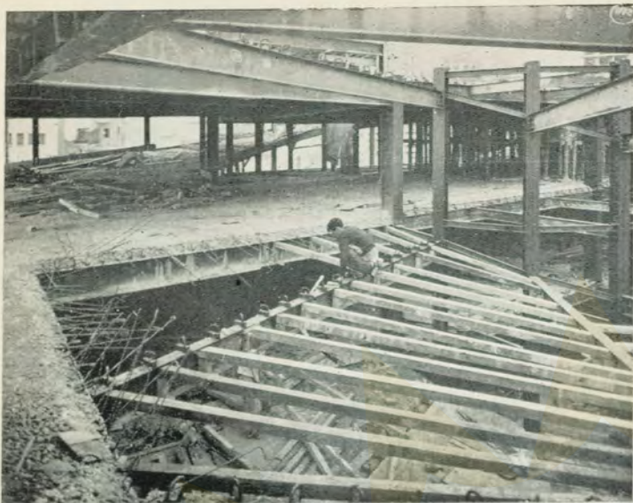
Preparo das formas para concretagem das rampas.
