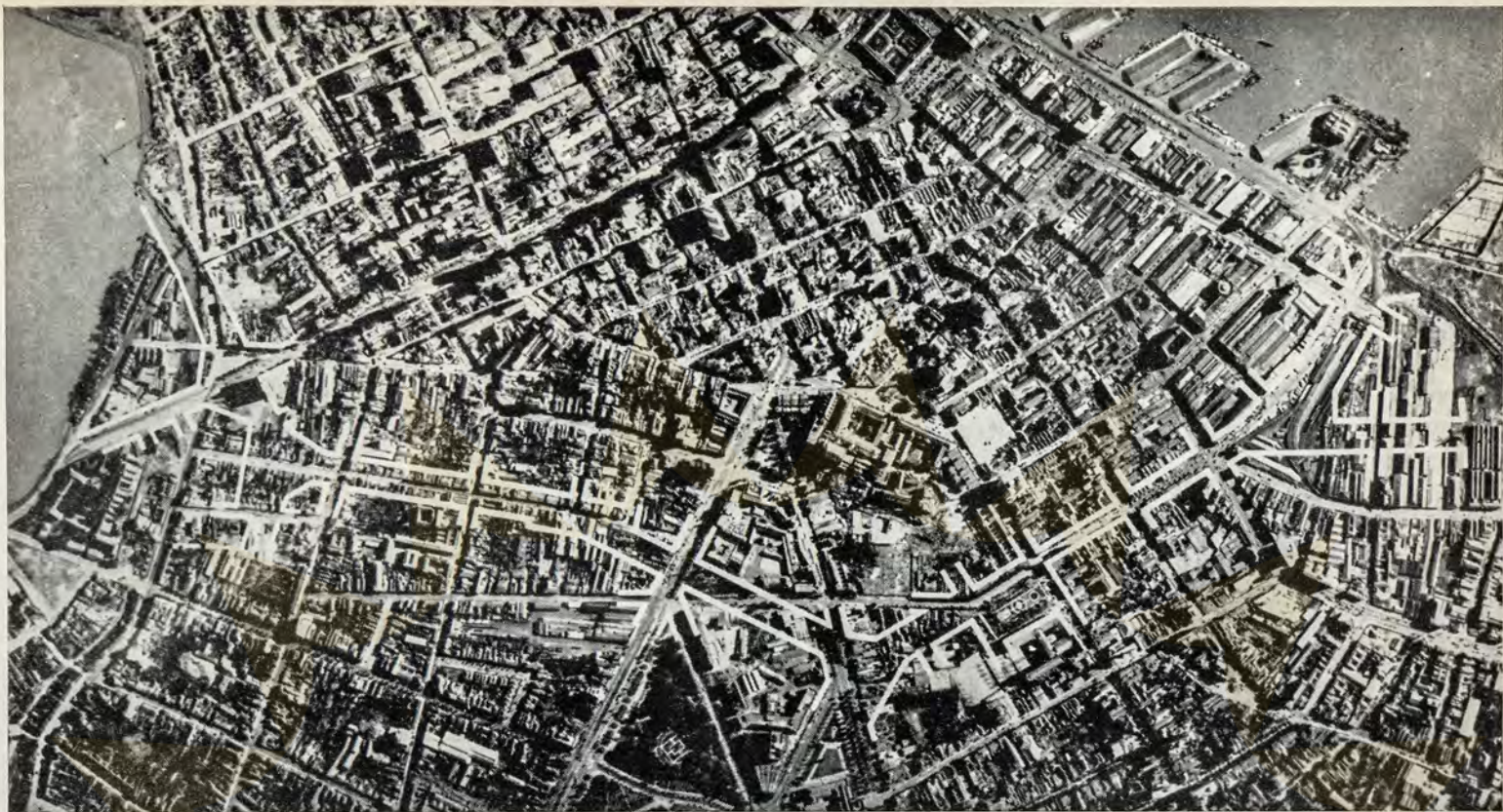
Fotografia aérea da zona central com o traçado definitivo da Avenida Perimetral.
