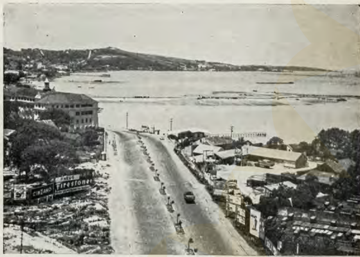
Local do cruzamento da Av. Perimetral com a Av. Borges de Medeiros, ao fundo, obras de aterro da praia de Belas (v/Habitat 32).
