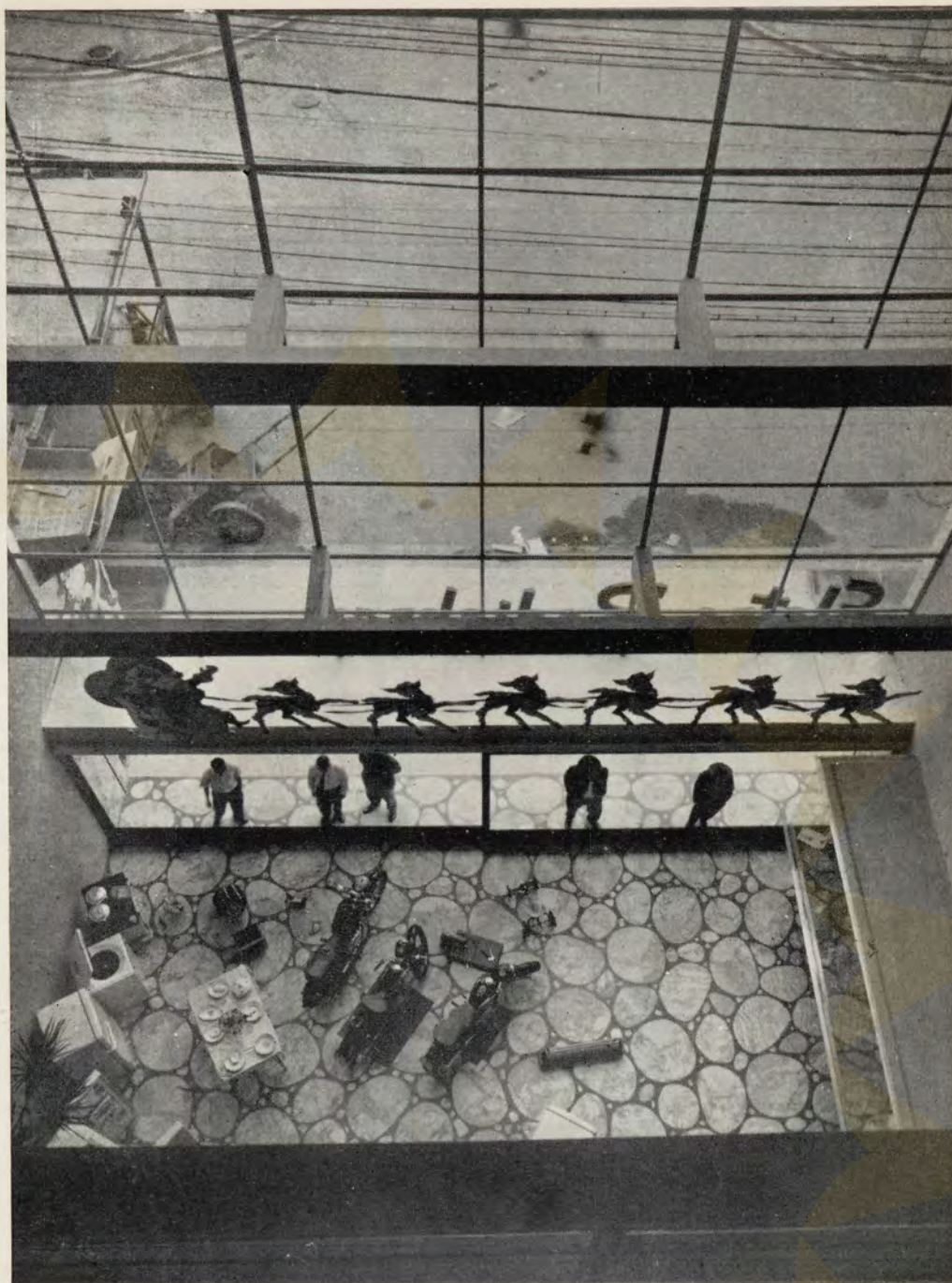
Vista interna da fachada tomada do 6.º piso.
