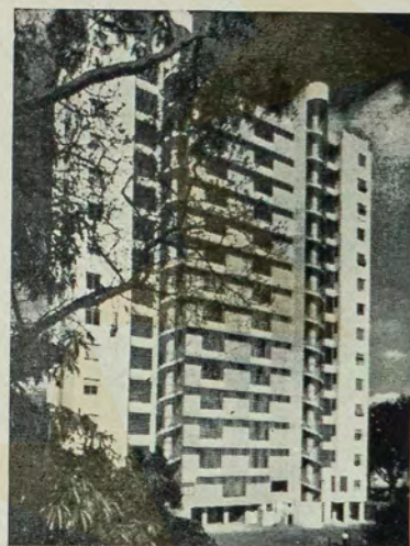
O primeiro bloco construído.
