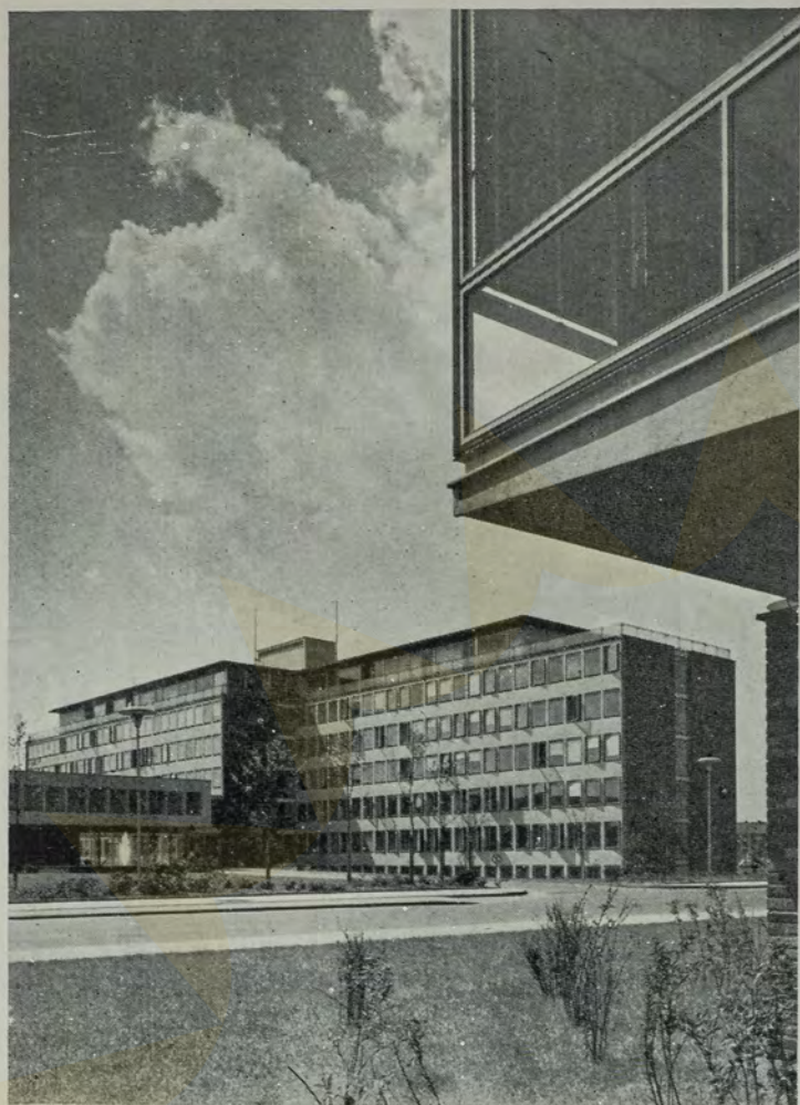
Aspecto bem característico da edificação classificada na categoria de Edifício para fins Comerciais, exemplificando o estado atual da arquitetura alemã.
