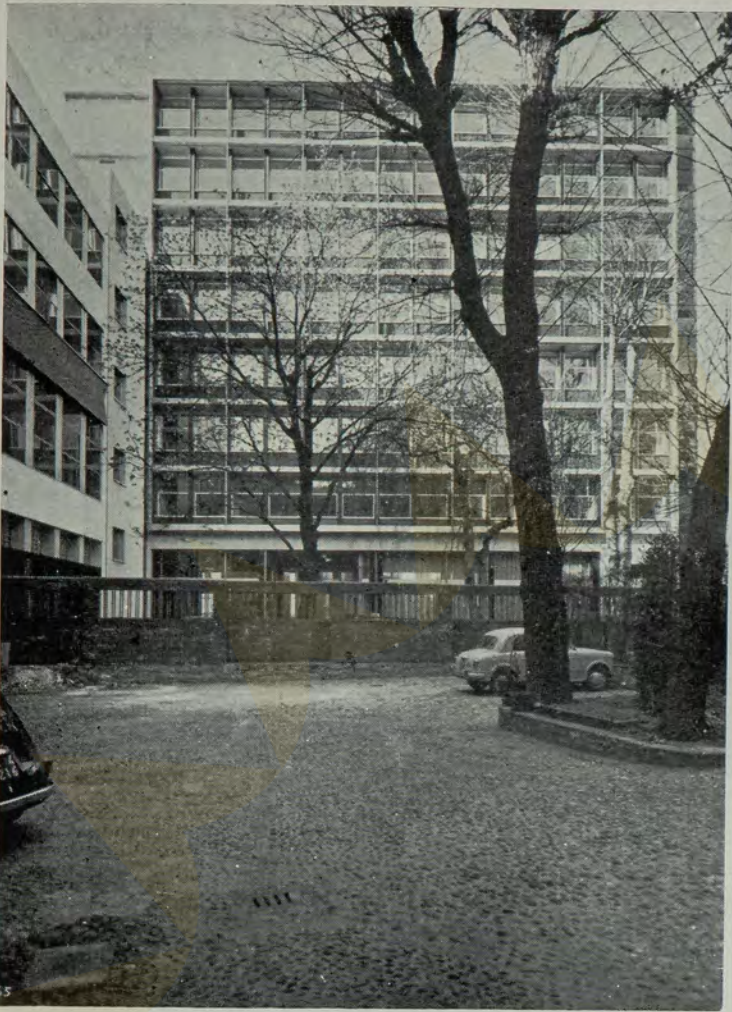
Do lado do jardim: a estrutura visível enquadra vasados mais nítidos e profundos, que realizam mais imediata comunicação entre os espaços fechados e abertos.
