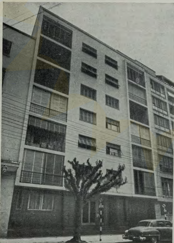
Prédio de apartamento na rua General Jordim, 51. A boa composição resultante desta frente dá a este edifício, quatorze anos depois, ainda, uma nota de modernidade, São Paulo - 1943.
