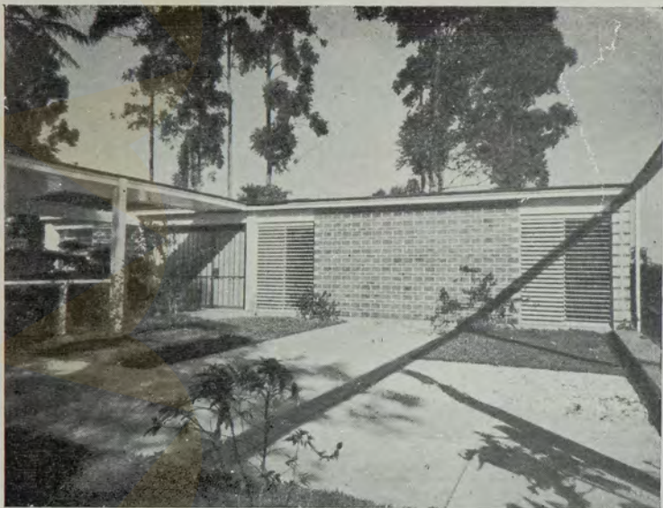
Aspecto do pátio interno, trabalhado em espaços retilíneos. Excelente aproveitamento em toda a organização.
