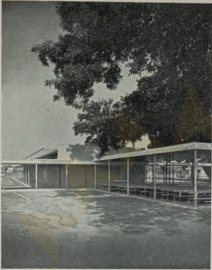
Local para as refeições e passagem coberta das classes. O ripado acima das janelas-clerestório protege da forte luz meridional.
