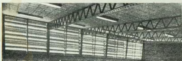
Detalhe do fôrro de um refeitório.
