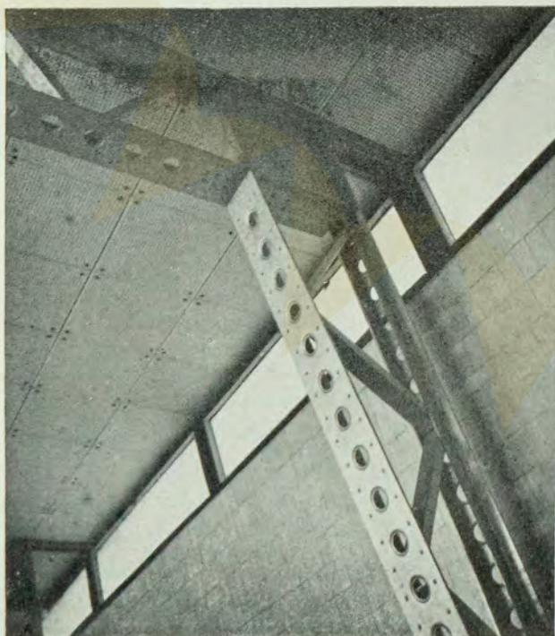
Detalhe da estrutura portante.
