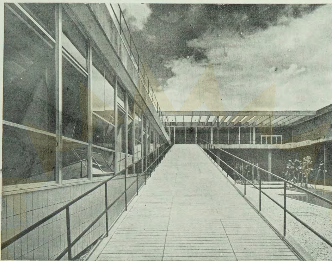
Rampa de acesso ao terraço-jardim junto ao restaurante.
