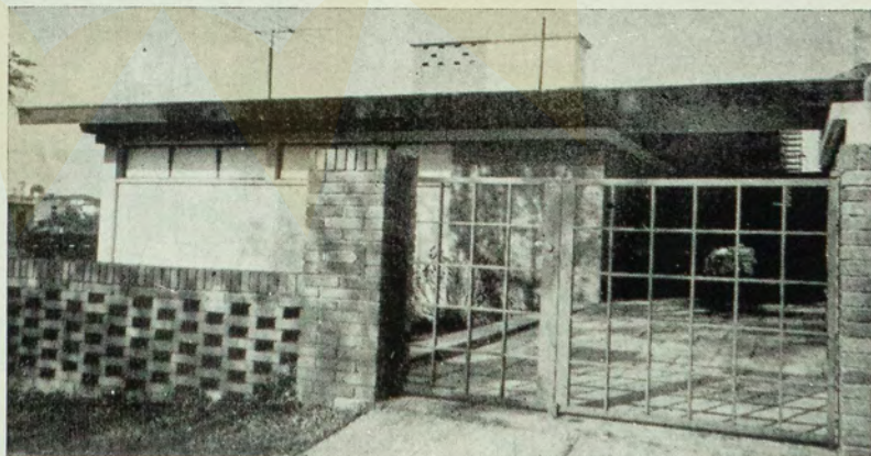
Entrada do apartamento superior, com garage.
