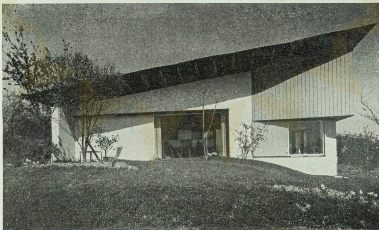
Arq. Hermann Mattern; residência perto de Kassel.
