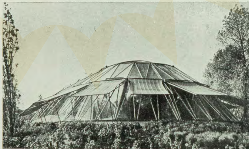
Arq. Bernhard Hermkes; pavilhão para exposição de flores e plantas ornamentais em Hamburgo. A estrutura é completamente em ferro, o piso em pedra natural.
