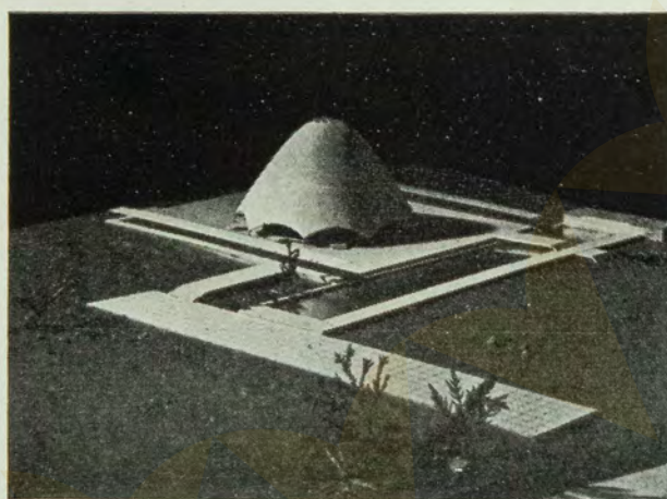
Arq. Paul Schneider-Esleben; vista geral da mesquita, à qual foi atribuído o primeiro prêmio. A cúpula redonda, com nove entradas, apoia sobre colunas de aço. A plataforma compreende cerca de 800 lugares. Sobre as nove entradas, a cúpula é dividida nas linhas de força estáticas e as altas janelas de vidro-cimento em volta da cúpula, também em número de nove, se encontram no vertice desta, formando uma estrela de nove pontas. Na frente um espelho de água, que tem significado simbólico. À esquerda, o edifício da Mannesmann A. G.
