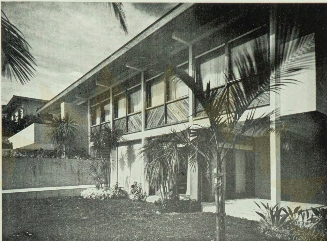
Fachada com amplas janelas, adornadas de madeira, vendo-se em baixo o jardim da entrada.
