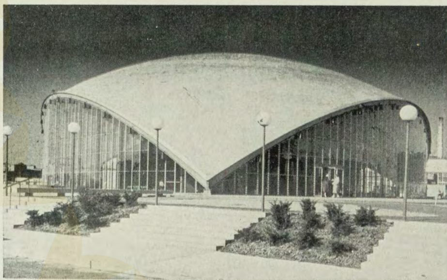
O Kresge Auditorium, do Instituto de Tecnologia de Massachusetts, com a sua cobertura apoiada em três pontos de aço, desenvolvendo-se em concreto armado.
