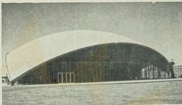
A cobertura, uma casca de cimento, emerge do chão como um elemento construtivo natural, definindo uma construção natural; mas é um excelente exemplo arquitetônico.
