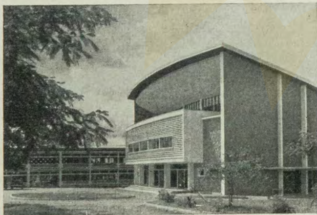
Trenchard Hall, com as instalações administrativas ao fundo. Ao alto distingue-se a parede externa do foyer, que consiste num V em concreto, formando uma parede respiratória. As paredes são revestidas de pedra local, as colunas pintadas de branco, estruturais e plásticas.
