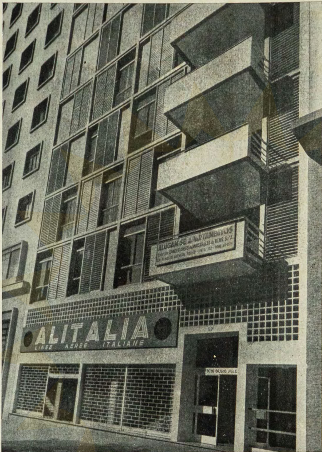
Detalhe do revestimento da fachada do edifício "Ouro Preto" em São Paulo, executado com pastilhas "VIPAX" ESTANDARD
