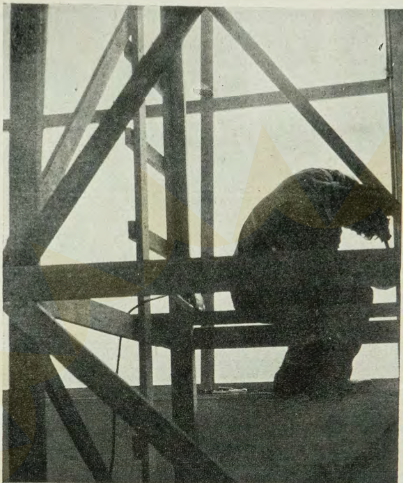
No afã dos trabalhos de ultimção do edifício.
