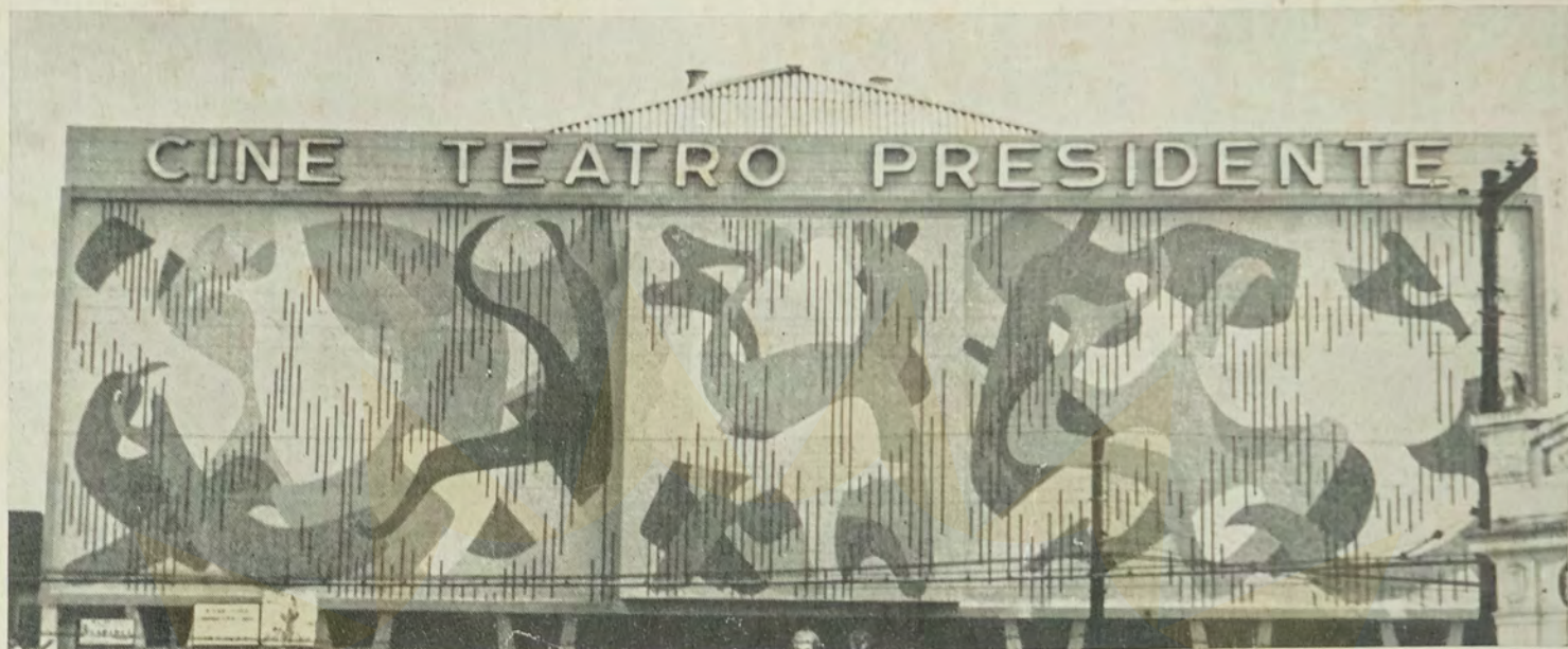
Painel executado com pastilhas "VIPAX" para a fachada do Cine Presidente em Porto Alegre
