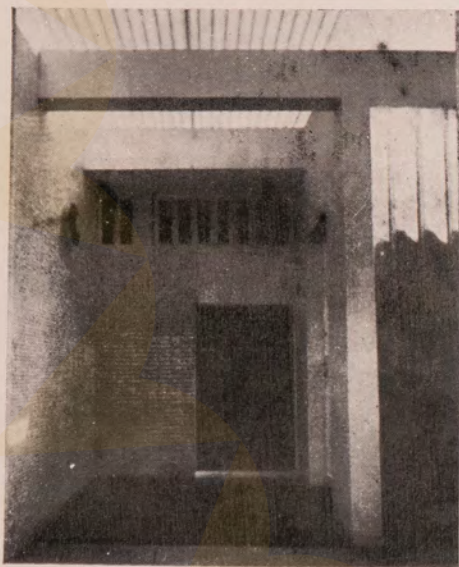
Pormenor da entrada lateral-doméstica: pastilha branca, litocerâmica e plástico amarelado.
