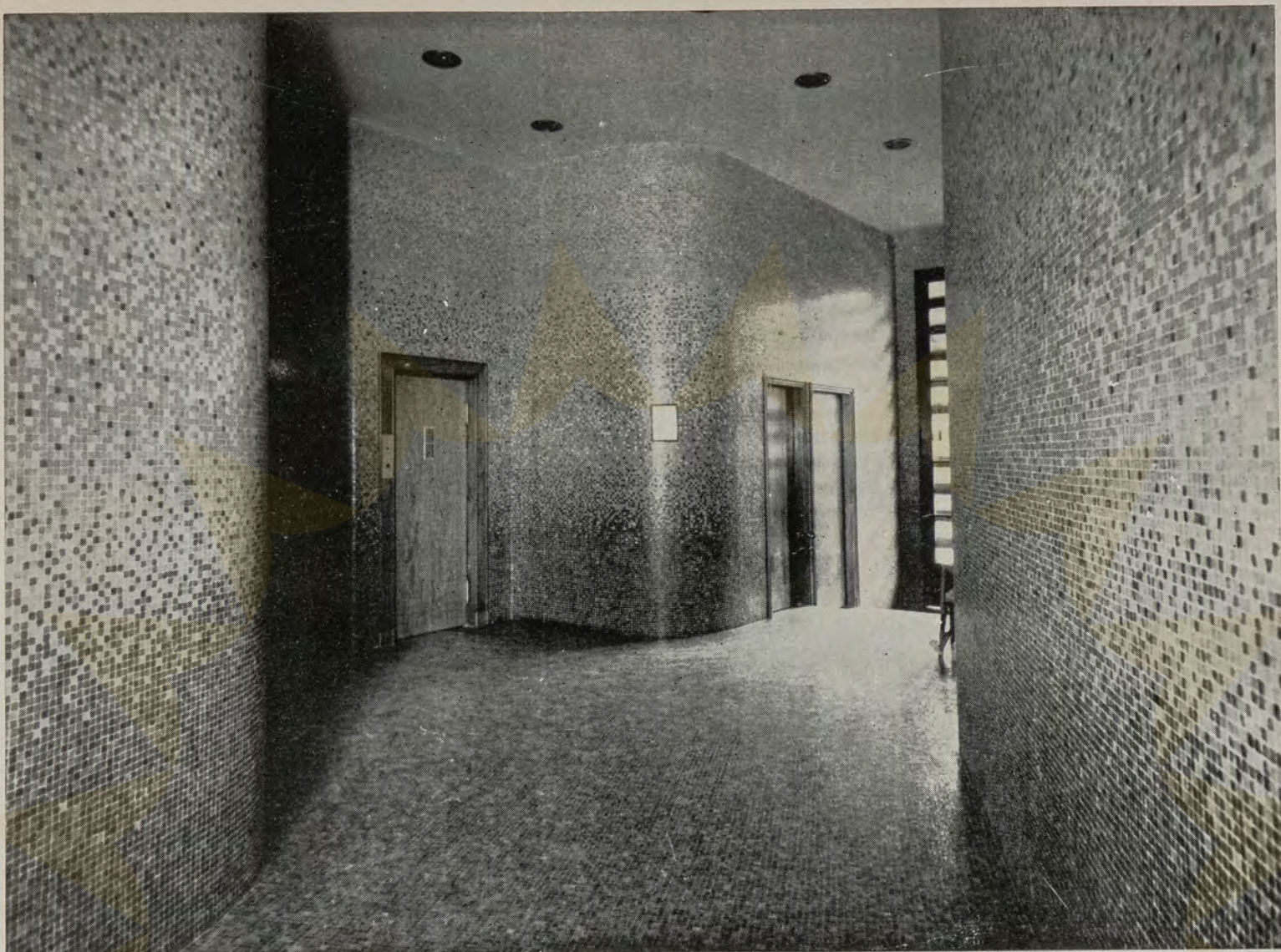
Execução em mosaico vidroso Vidrotil
