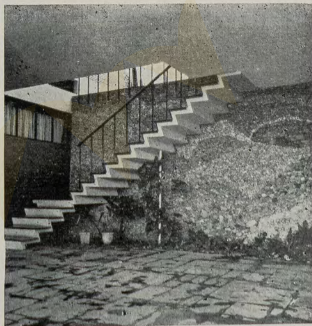
Vista interna do terraço coberto. A escada, em concreto armado, presa somente nas duas extremidades, fica em frente a uma parede revestida de seixos rolados.
