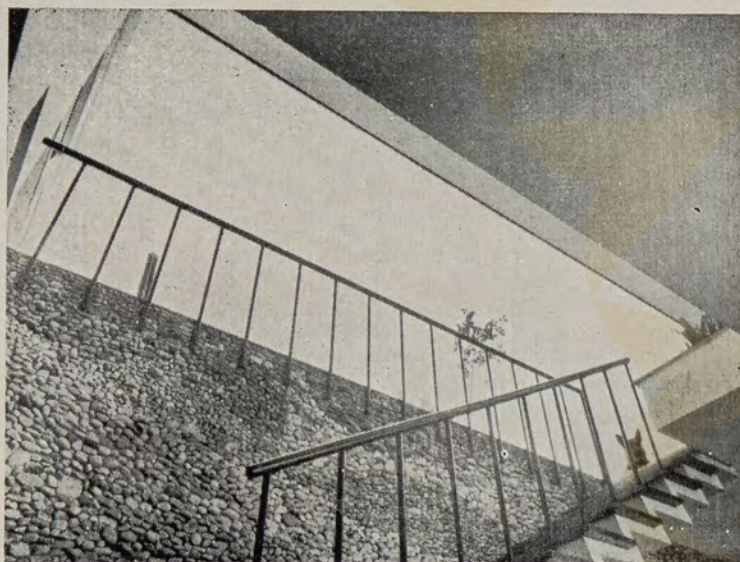
Detalhe da escada que liga o térreo ao pátio superior. O acesso dá a quem chega ao alto uma agradável vista para o pátio.
