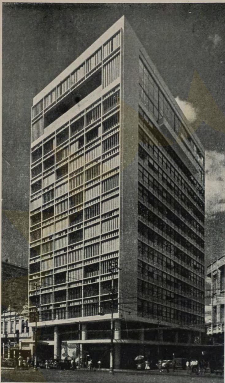
Imponentissima implanta76o do edif6cio-sede do Clube de Juiz de F6ra, visto do cruzamento da sua situa76o na avenida Rio Branco com a rua Halfeld — frente de quebrass6is, voltada para a pra76a.
