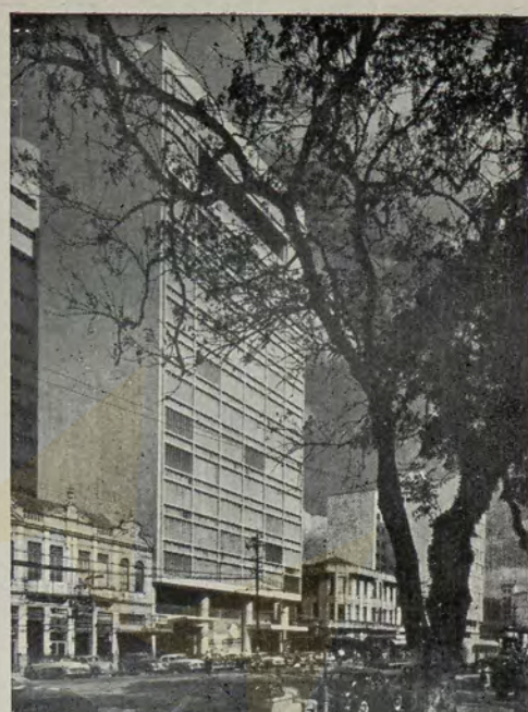
Perspectiva da distância, lado da avenida Rio Branco.
