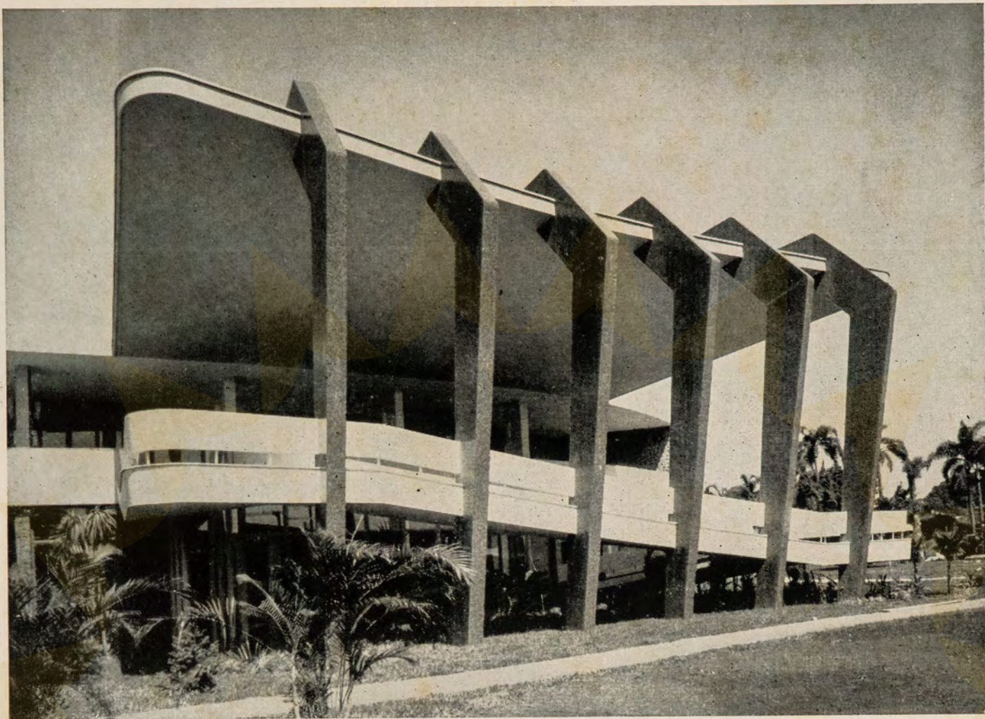
Execução em mosaico vidroso Vidrotil
