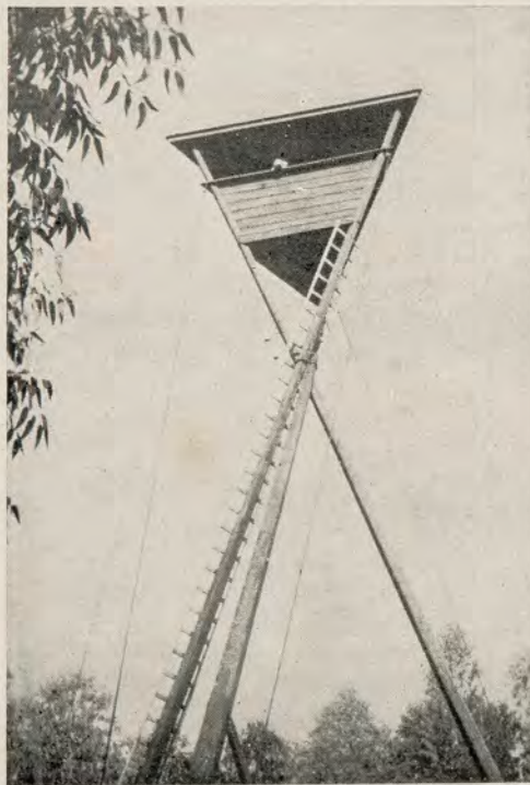
Para prevenção e combate aos incêndios, construiu-se uma torre de vigia. Sua altura é de 19 metros até a ponta. Cabos finos dão estabilidade à construção, mesmo em caso de ventania. Um posto telefônico funciona no alto.
