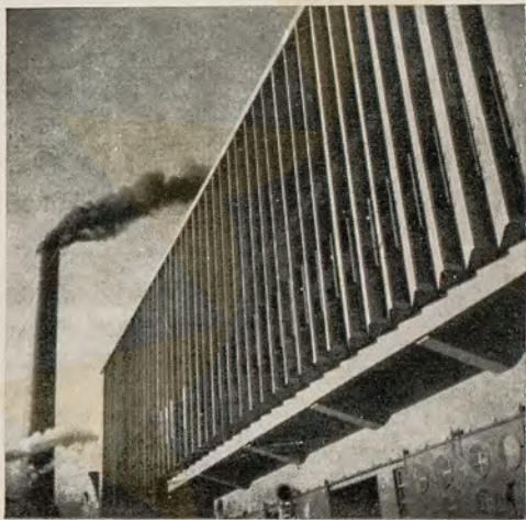
Na ampliação da primeira fábrica, localizou-se uma outra máquina neste edifício, onde foi necessário impedir que o sol entrando amarelasse o papel. O sistema de quebrassol permanente cobre um espaço de 12 metros de altura, tendo-se logrado uma diferença de 8 graus, menos, na temperatura interior. A altura do edifício é de 21 metros.
