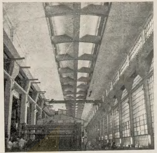
Outro aspecto do interior, podendo-se observar ao centro a canalização de água. A largura que cobre o vão é de 14 metros; ao alto, engenhoso sistema de apoio no fecho do arco de concreto.
