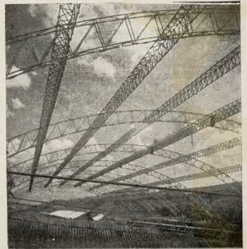
Grande galpão — aspectos da construção e da obra acabada. Sobre a trama de ferro soldado colocou-se a camada de concreto, passando-se à fase final da cobertura, como se vê na fotografia da obra acabada.
