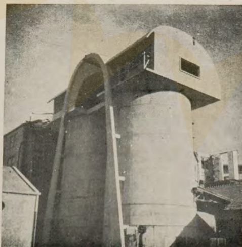
Torres destinadas à formação da massa de papel, chamadas torres de alta consistência.
