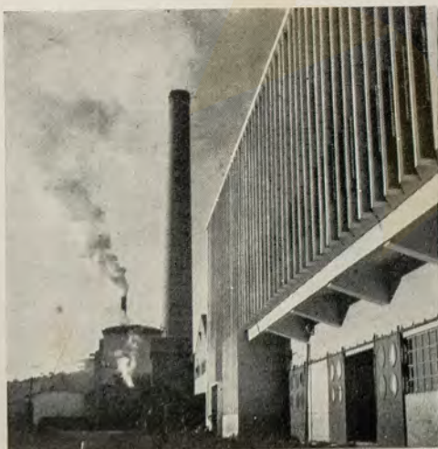
Detalhe da sustentação em balanço do quebrassol em concreto estucado. A largura do apoio é de 2,80 m.
