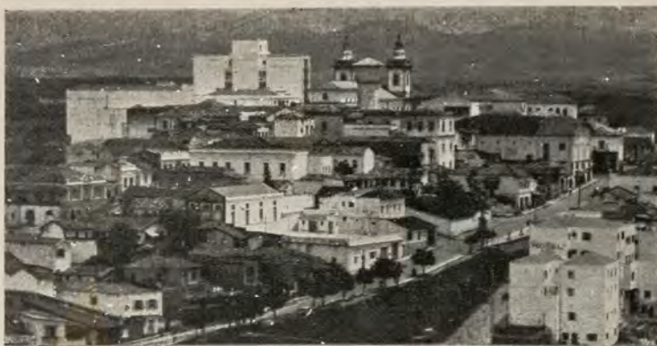
Vista da cidade de Aparecida do Norte, focalizando a Basílica e a construção do hotel.
