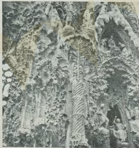
Igreja da Sagrada Família. Detalhes estruturais.
