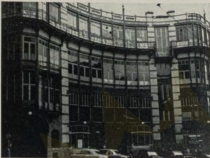
Aspecto da fachada.
