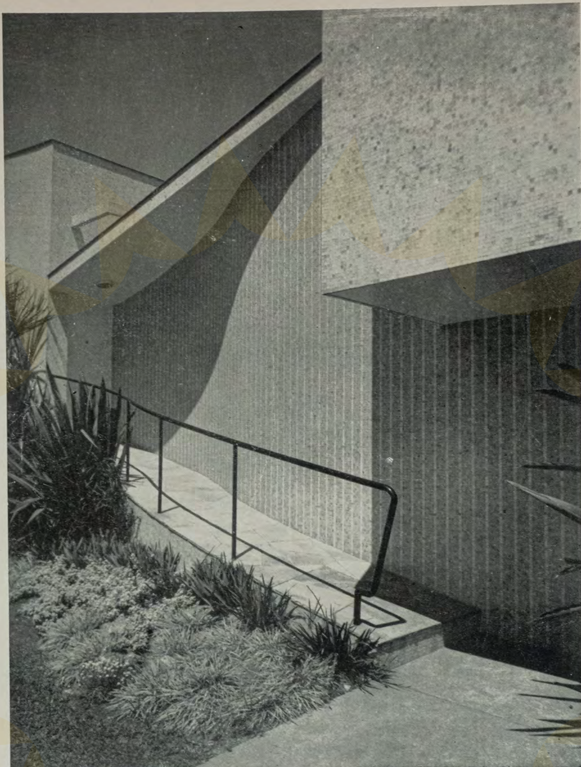
Execução em mosaico vidroso Vidrotil
