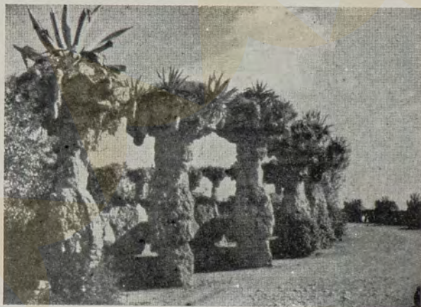
Parque Güell, alameda com pilares, em forma de árvores.
