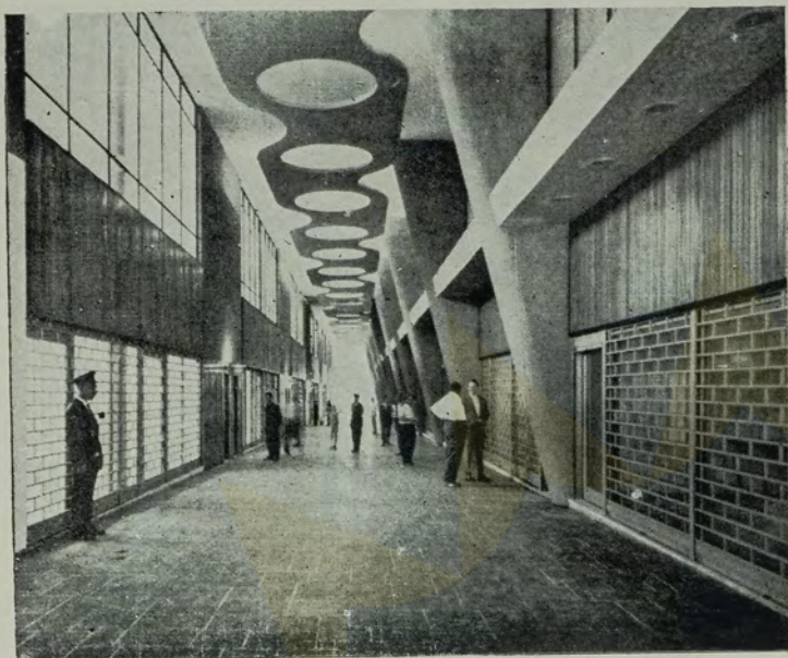
Vista da galeria interna, sob o bloco maior, que liga a av. Paulista com a rua S. Carlos do Pinhal. O piso é de arenito polido e o revestimento das colunas à direita é de pó de pedra cinza, fixado sob pressão e polido. A iluminação é toda indireta a luz fria, e o revestimento das paredes foi composto em madeira e plástico.
