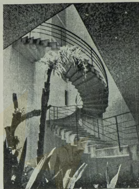
Escada que liga o andar térreo com o terraço-jardim. A leveza da estrutura de concreto, servida pelas fitas de ferro protetoras, as placas de granito cinza, tudo compõe uma forma elegante e elástica.
