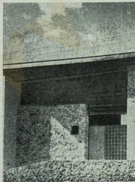
Pormenor do uso da pedra em relação ao cimento e ao vidro e ao alto a parte fechada com madeira.
