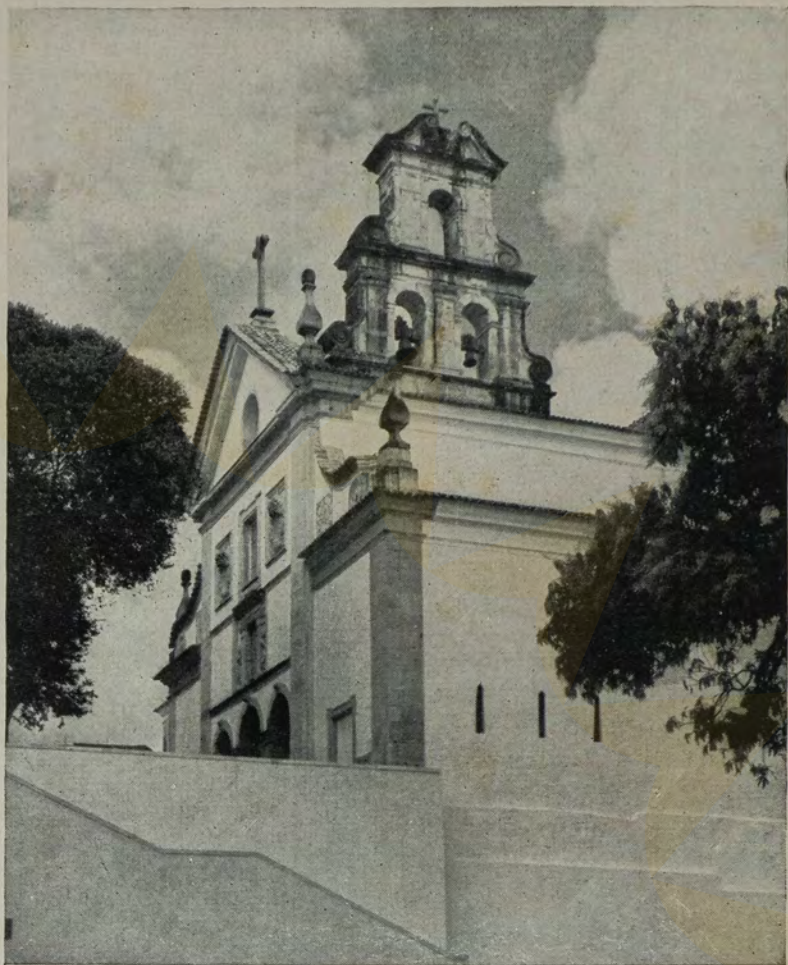
Fachada lateral com a torre-sineira do velho Convento de Santa Teresa, Salvador.
