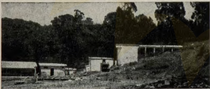
Estação de tratamento dos esgotos sanitários, em ciclo completo da WILLYS-OVERLAND DO BRASIL S/A .
