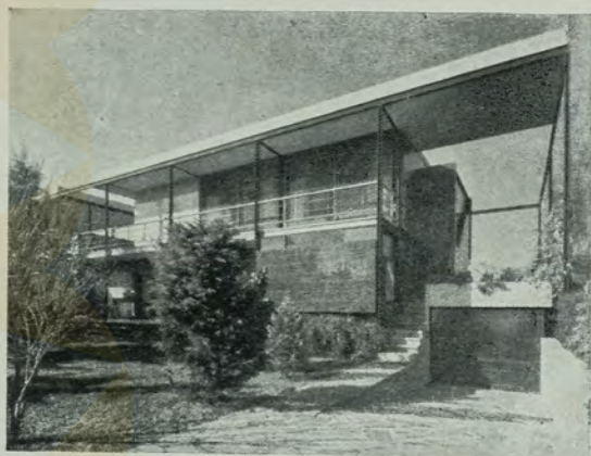
Fachada principal podendo-se observar o partido tirado da estrutura de aço pintada em negro mate, como uma constante do desenho.
