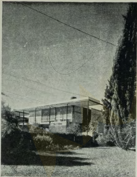
A residência Oks vista de um jardim vizinho.
