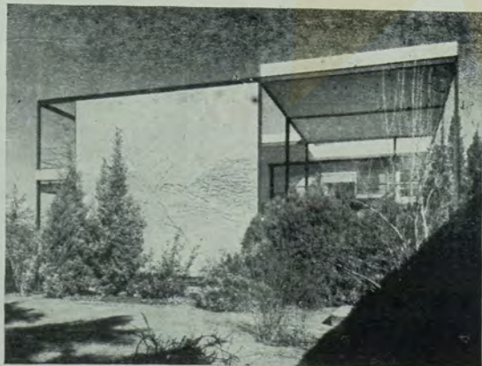
Fachada lateral em que os elementos já consignados continuam inerentes à feição decorativa acompanhando as formas.
