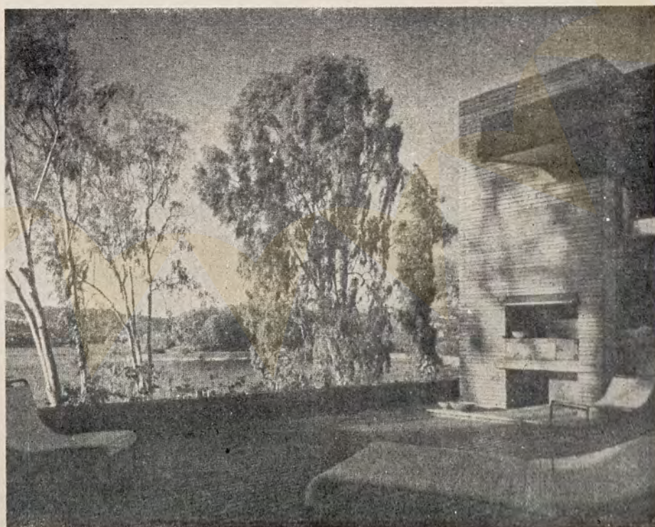
Terraço no teto da casa, com elevador de serviço, Churrasqueira e lareira aberta.
