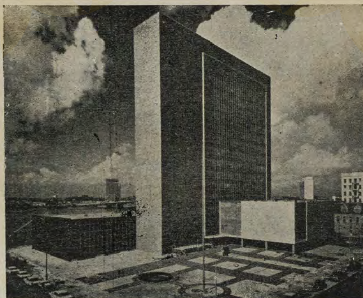
Edifício da Prefeitura de Jacksonville.
