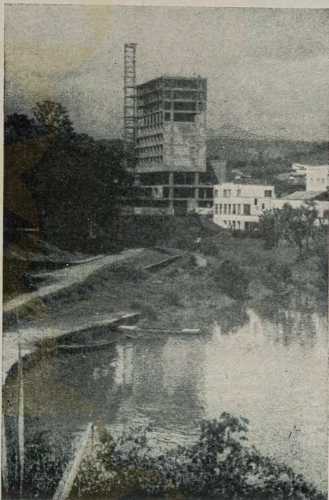
Grande Hotel Blumenau, Vista da atual fase da construção, tirada do Rio Itajaí.
