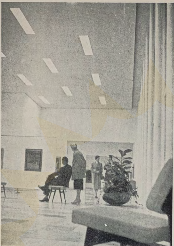
Sala de exposição com iluminação de luminários encravados no teto com gelosias de laminais metálicas. Cada luminário leva duas lâmpadas fluorescentes tubulares.
