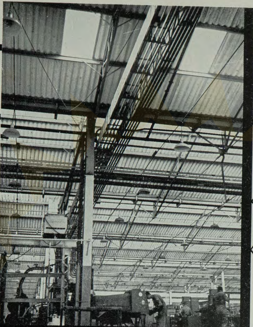
Aplicação de chapas onduladas Eternit com chapas plásticas "Luzalit" na Indústria de caminhões Mercedes Benz do Brasil S. A. - São Paulo.
