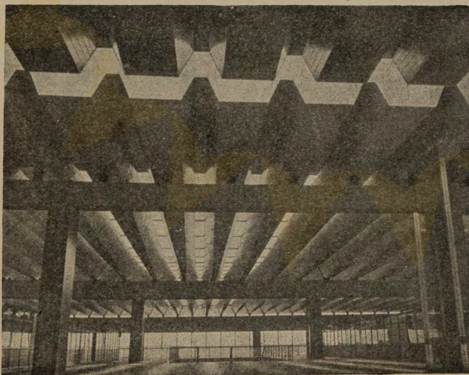
A cobertura do salão é realizada com nervuras portantes em estrutura celular em V aberto, contínuas sobre uma série de travas recolhedoras em cimento armado.
