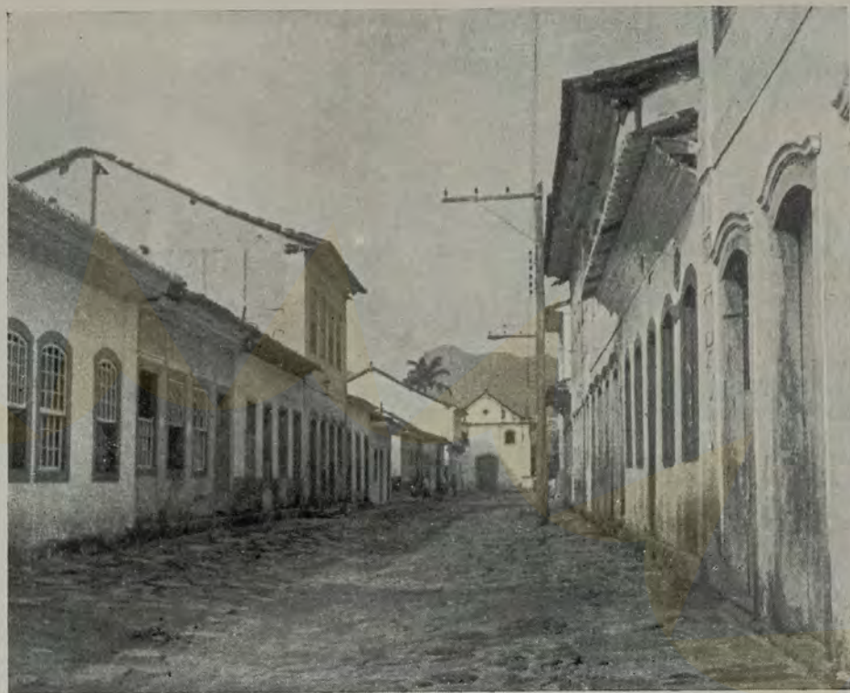
Rua de Parati: ao fundo, Serra de Cunha.
