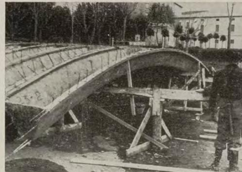
Elementos prontos para a montagem. Observar as peças para ligação com a parte superior e com os apoios
