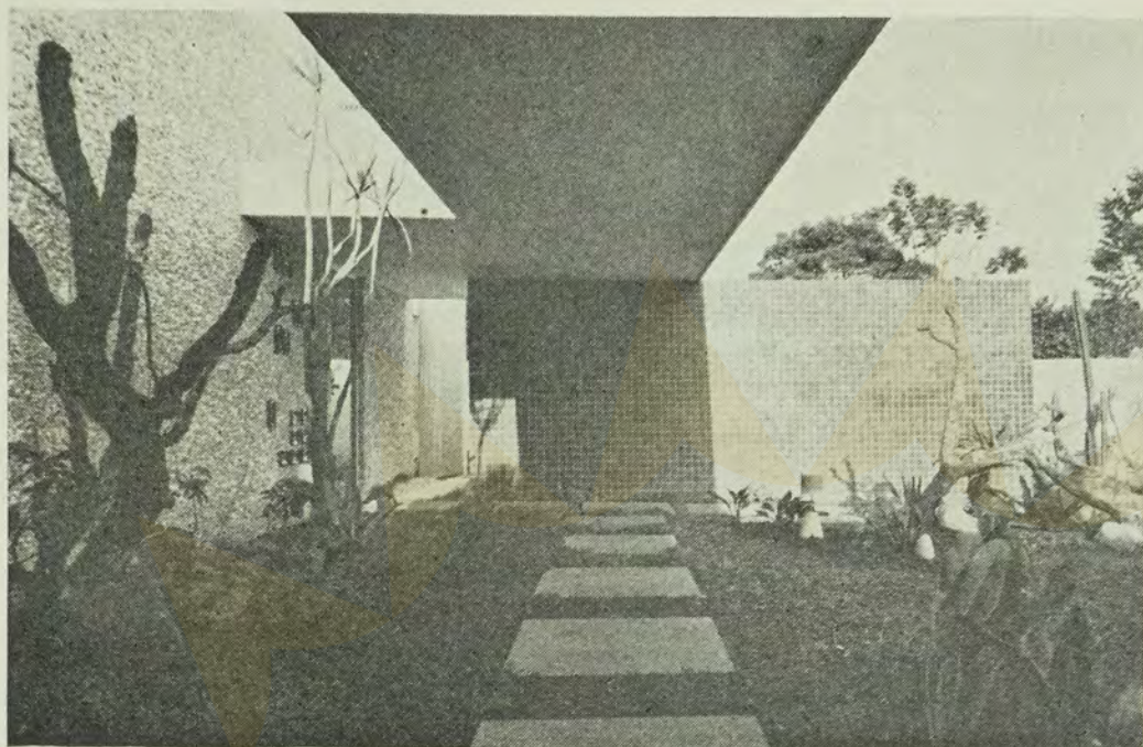
Vista de baixo da marquize para a parede de cerâmica preta com a entrada principal.
