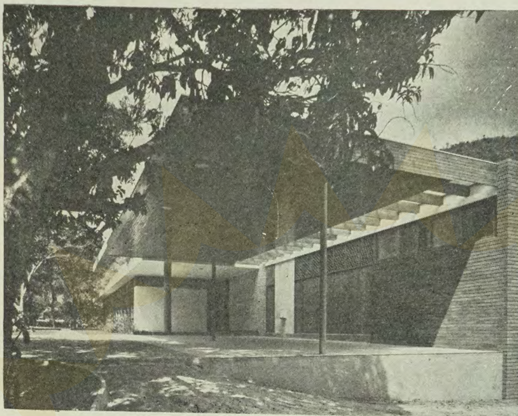
Outro ângulo bem sugestivo, na parte da pérgula, revestida de madeira e coberta com telhas plásticas translúcidas.
