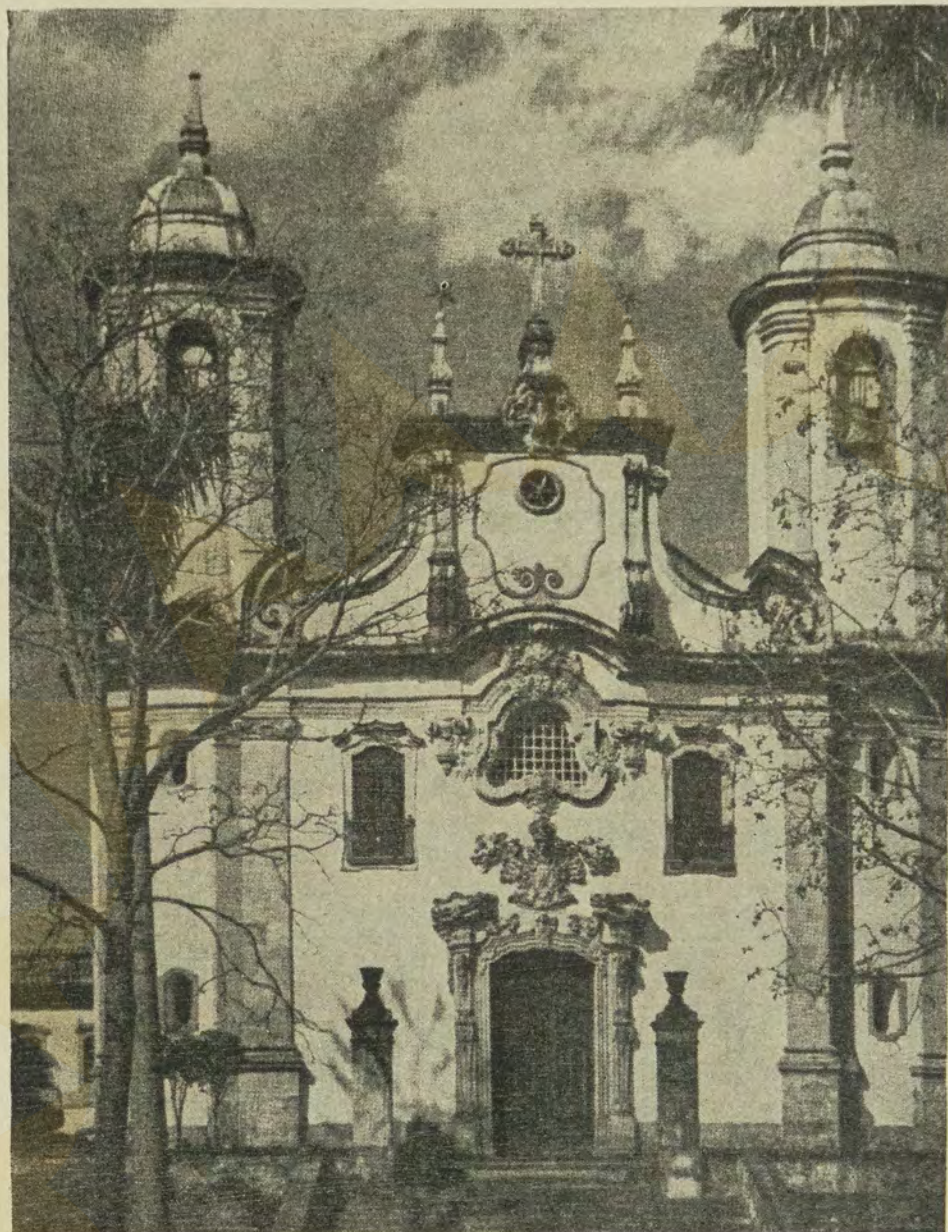
Fachada da Igreja Nossa Senhora do Carmo, Ouro Preto.
