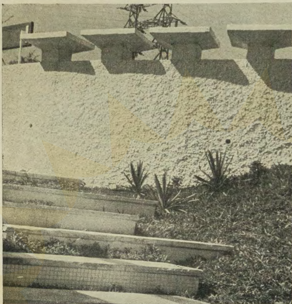
Vista de parte do acesso direto da rua Av. Jardim. Infelizmente, os degraus não ficaram isolados do piso como previsto; entre um e outro, usam-se plantas rasteiras variadas como vinca major, ajuga reptans, Sedum amecanum e Stachis lanata .
