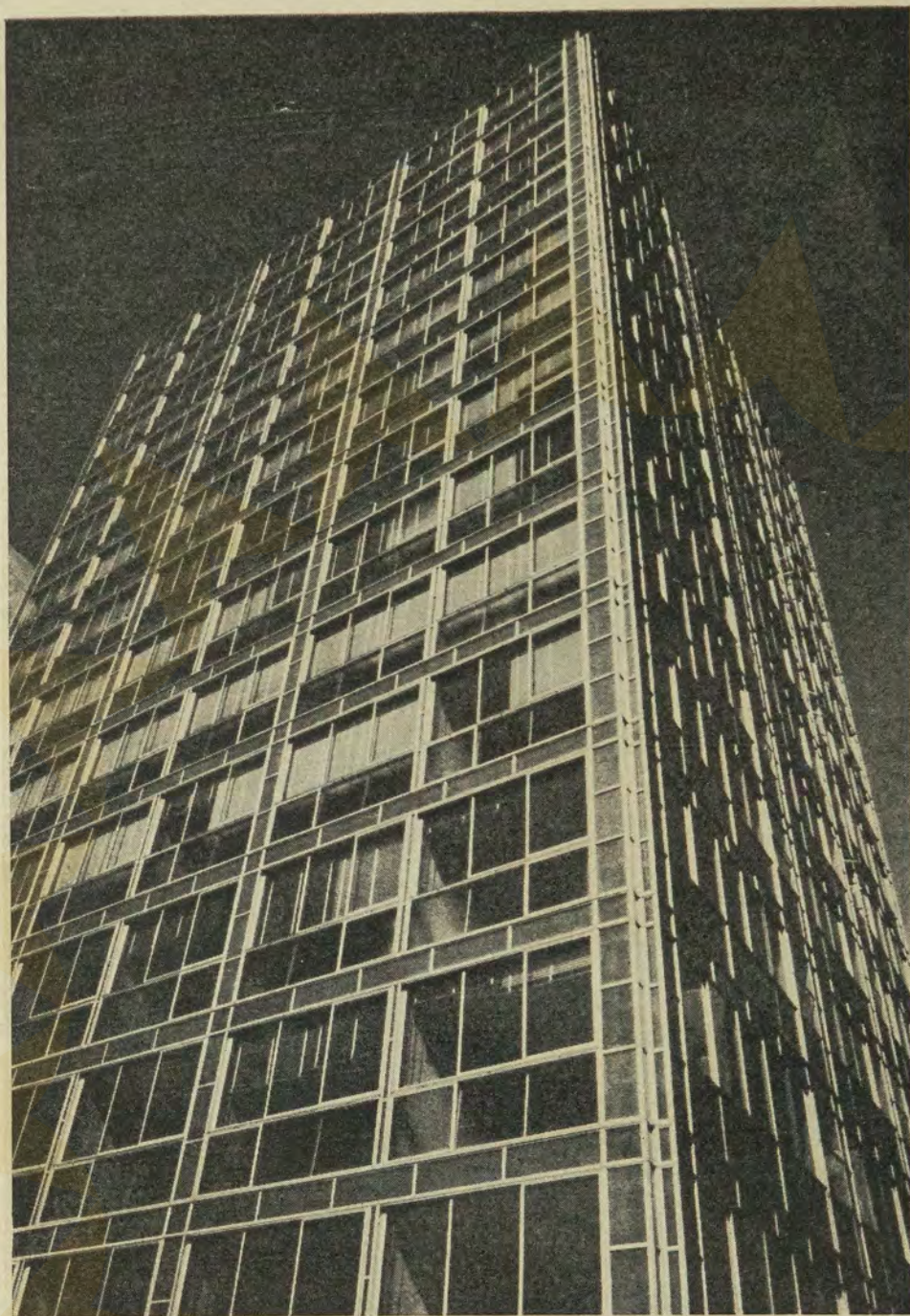
O corpo do bloco de escritórios; caixilhos de alumínio e vidros "Anti Sun".
