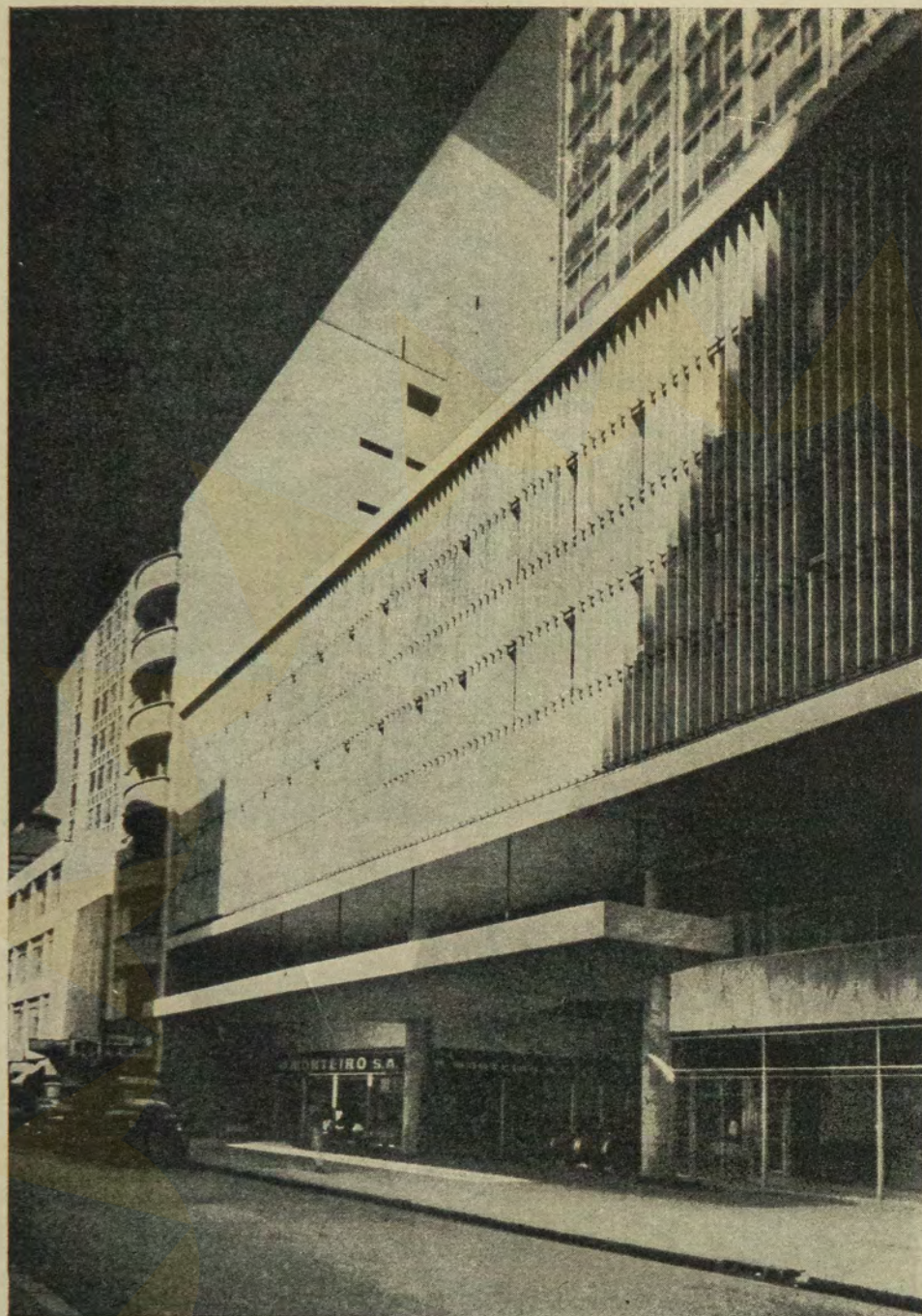
Fachada sôbre a rua. O corpo superior é recuado. Notem-se os tirantes de sustentação da marquise.
