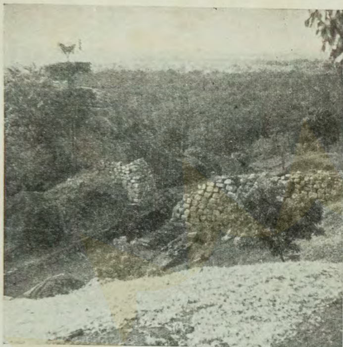
Construção ao pé do rochedo.
