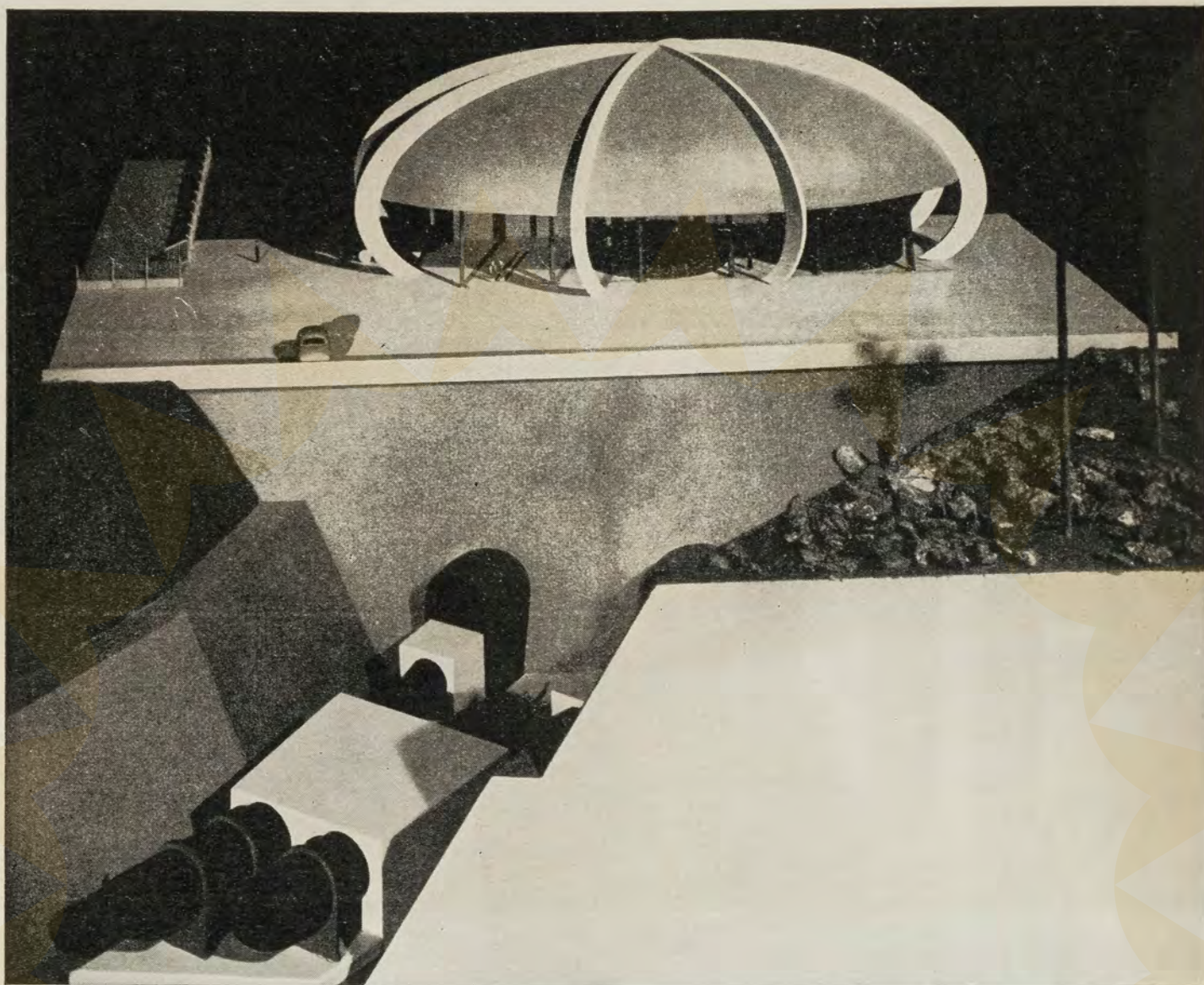
Vista da entrada dos “condutos forçados” no nível das turbinas. Todo êsse canal será aberto na rocha, servindo esta como revestimento.
