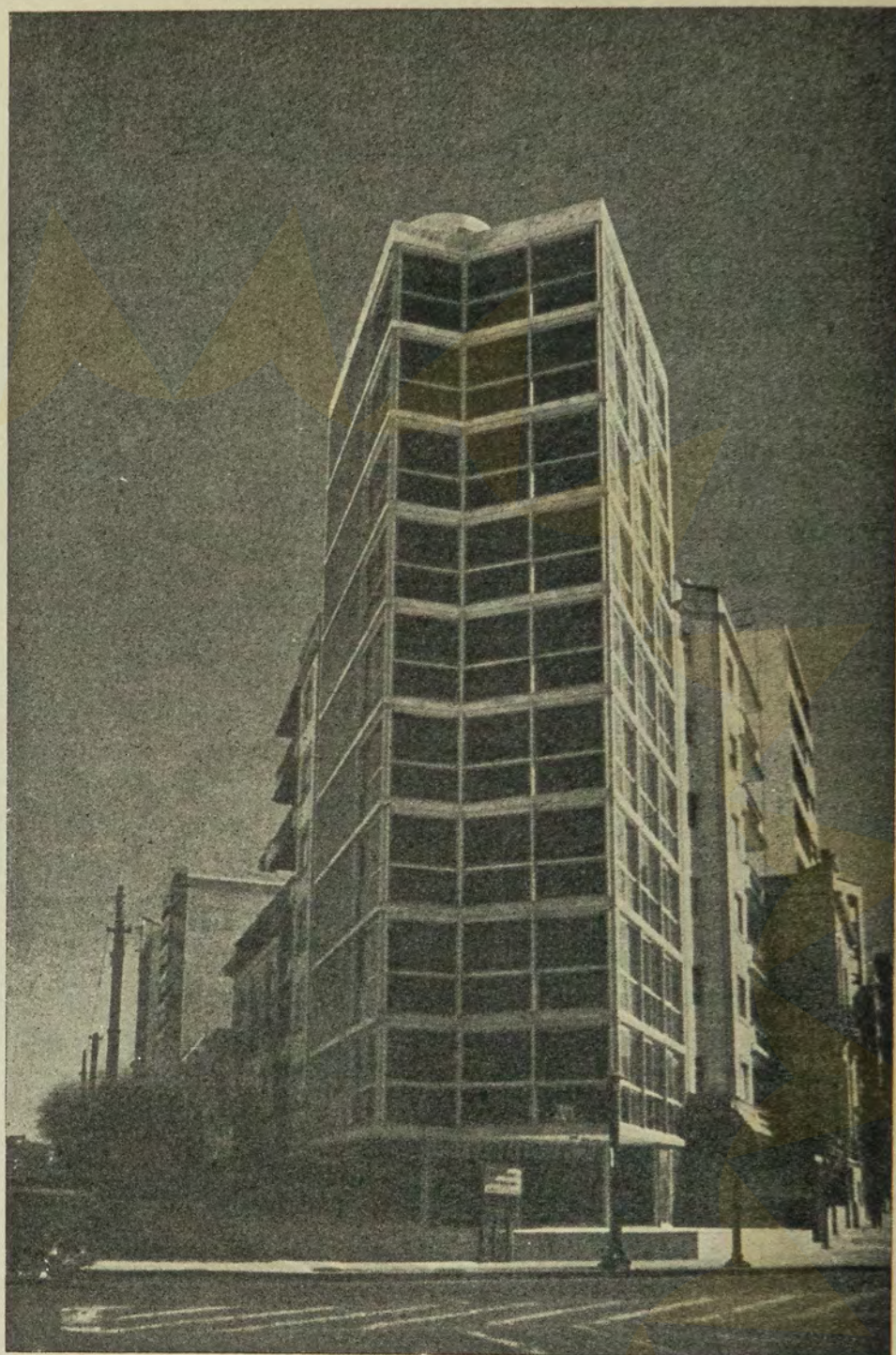
Edifício "El Pilar", Montevideu, Uruguai. Projeto dos arqs. Luís García Pardo e Alfredo N. Farini.
