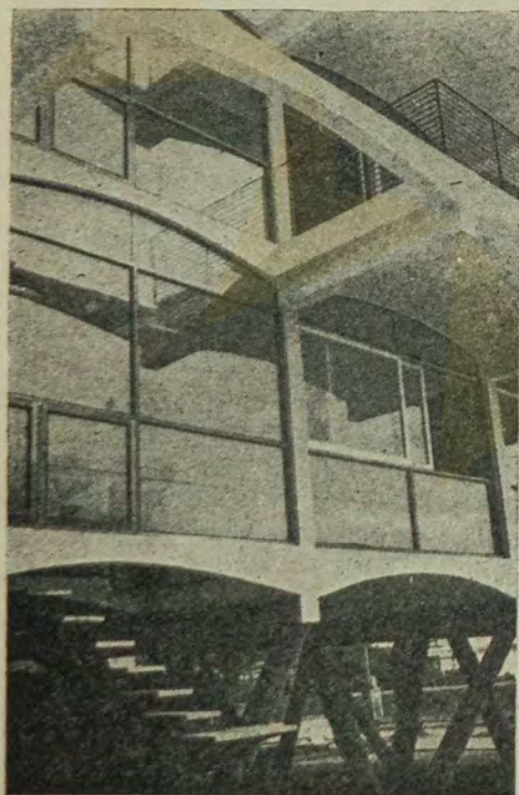
Detalhe de uma das escadas e balcões. Edifício "Ruca Malen", Punta del Este, Uruguai. Projeto dos arqs. Luís García Pardo e Alfredo N. Farini.
