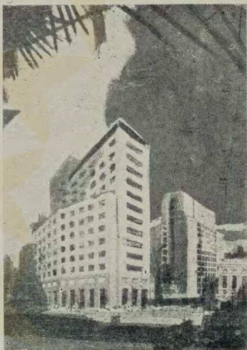
O «BOILER» do edifício do National City Bank é de nossa instalação.
