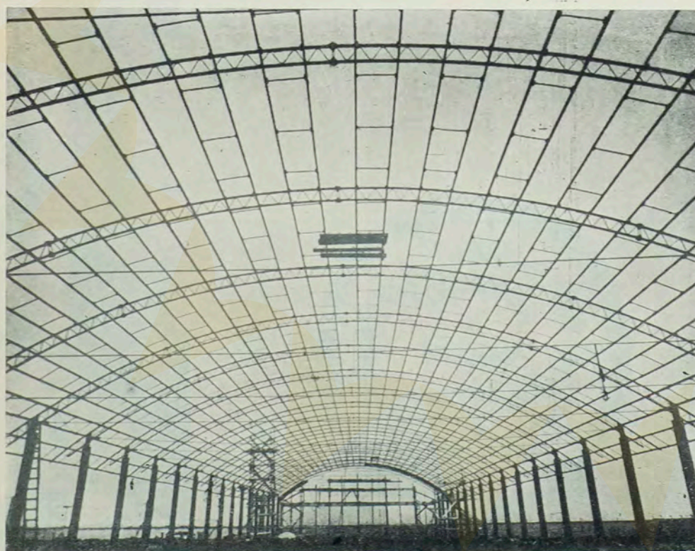
Estrutura de ferro — Vão livre 24 ms. C.M.T.C. — Garagem de ônibus, Vila Leopoldina
