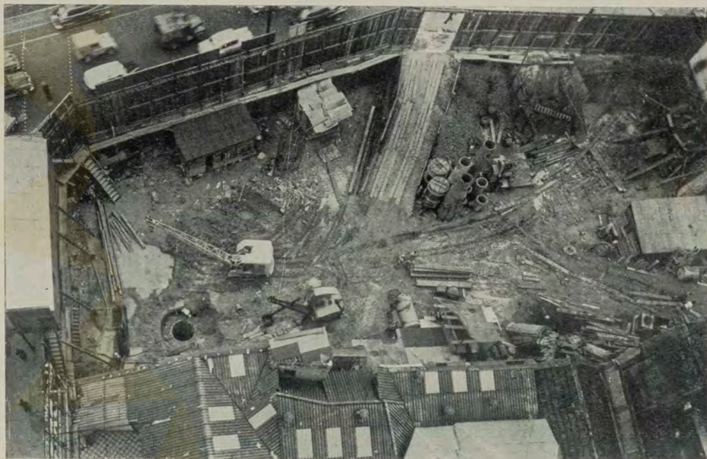
Execução das fundações.
