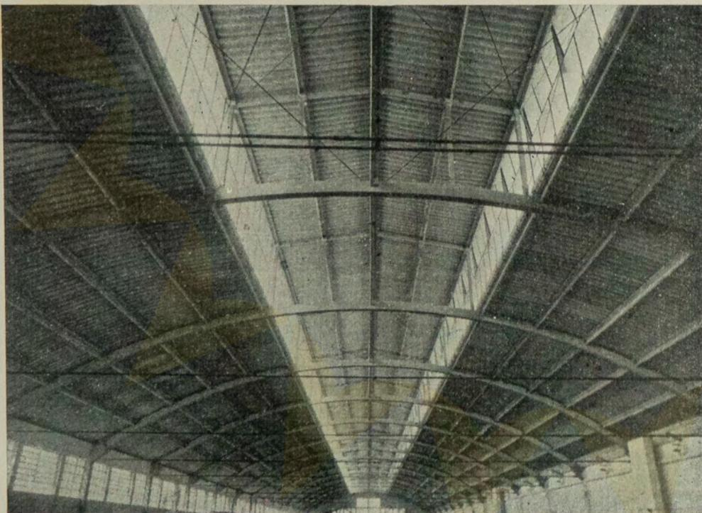
Estrutura para telhado compreendendo arcos e terças de concreto armado pré-moldado — Vão livre 23,30 m — POÁ
