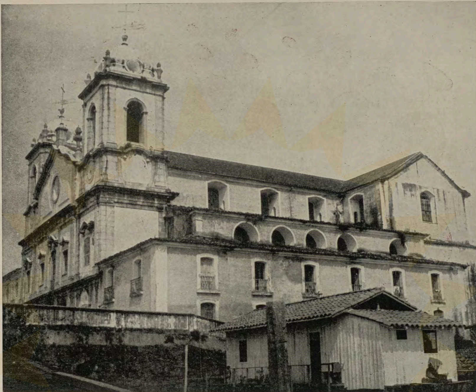
Arquiteto Antonio José Landi, Igreja de N. S. do Carmo, Belém do Pará, 1766 (Foto Celina Magalhães)
