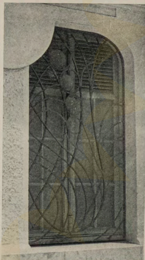
A janela do porão. Compilar a variedade destas janelas no período "floreale", seria recolher um curioso material sobre a inesgotável imaginação dos serralheiros e arquitetos do começo do século. Este é um exemplo encontrado na rua Aurora, 102, em São Paulo
