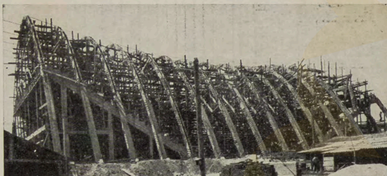
Cimbramento completo com todos os arcos. A estrutura, nesta fase, está pronta para receber os elementos pré-moldados
