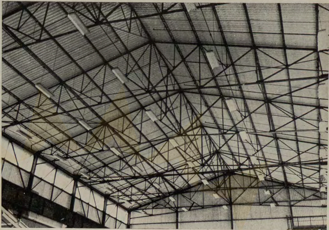
Teto do armazem de descarga
