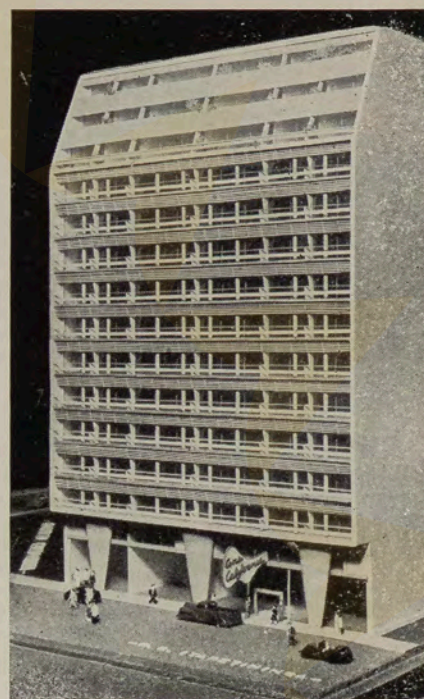
Edif. e Gal. Califórnia, fachada para R. B. de Itapetininga, S. Paulo
