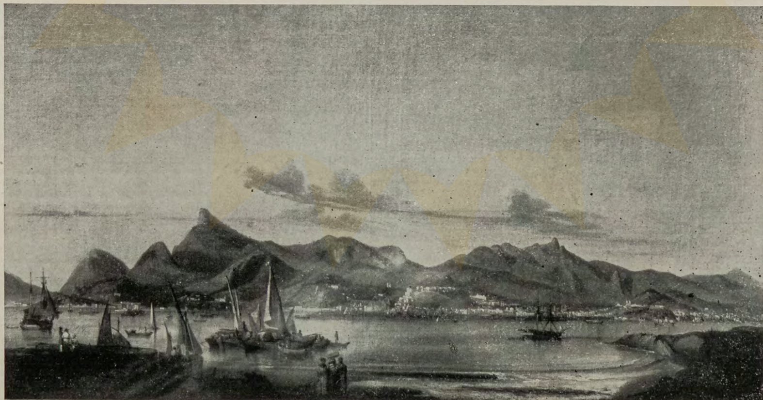
Etienne François Auguste Mayer (1805 - 1890). Vista da cidade do Rio de Janeiro tomada do patio da igreja de N. S. da Glória do Outeiro em 1844. Coleção Cavalcanti de Lacerda, Rio
