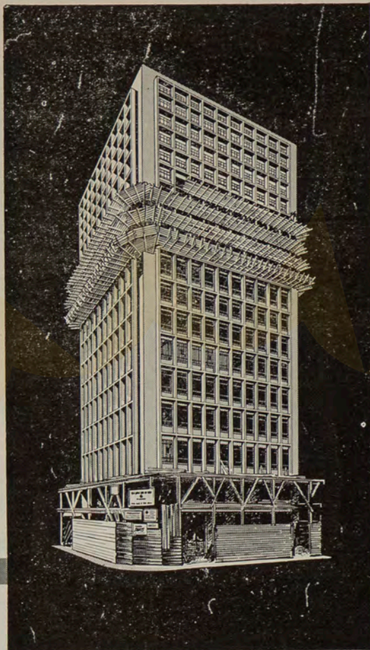
Edifício da Caixa de Seguros de Vida dos Funcionários Cíveis e Militares do Paraná (obra iniciada em junho de 1952)
