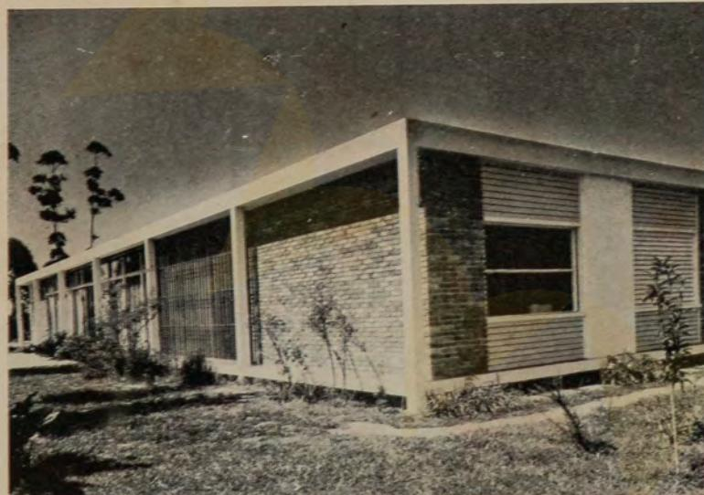
Vista dos dormitórios, lado norte. Na face nascente existe um caixilho de vidro de 14 metros de comprimento. Como medida de proteção, foi usada uma grande corrediça que se recolhe sobre a parede de tijolos
